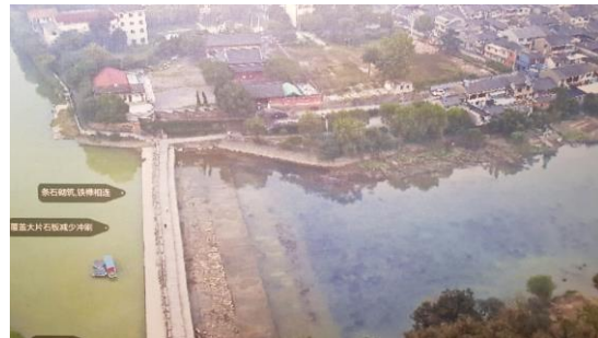
Hình ảnh đập tràn được xây dựng 400 năm trước công nguyên đến nay vẫn hoạt động
