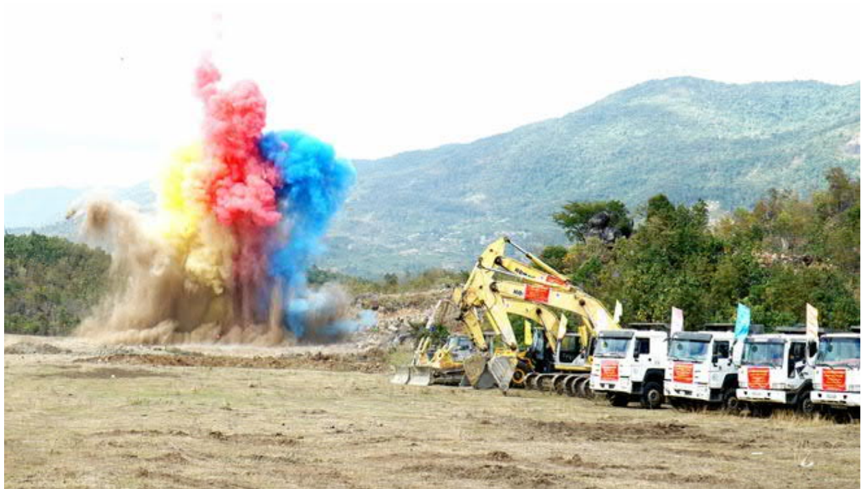
Khởi công dự án thủy điện tích năng đầu tiên của Việt Nam tại Bác Ái (Ninh Thuận)
