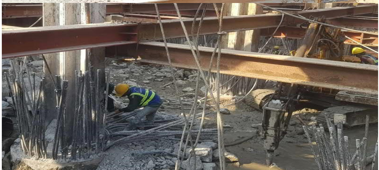
Không gian thi công chật hẹp.
