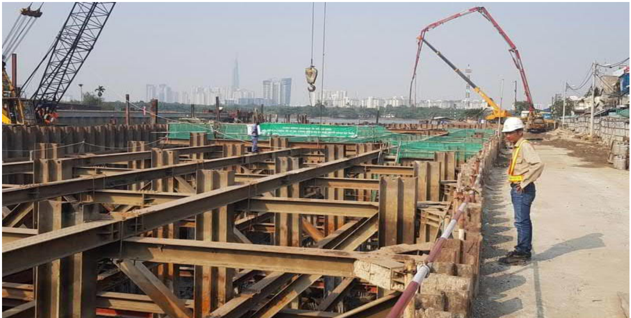
Đang thi công đào sâu xuống đáy sông., phía xa là trung tâm quận 1 với các tòa nhà cao
