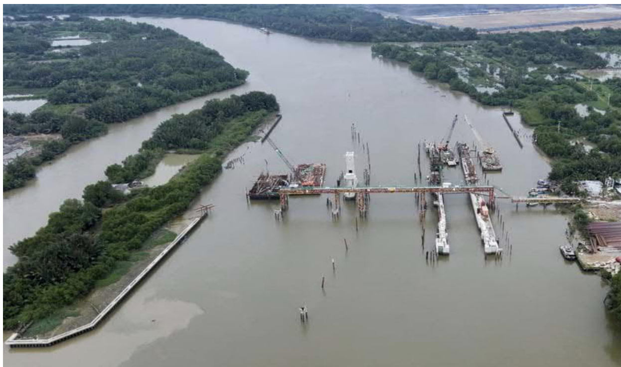
Cổng Cây Khô nằm trên rạch Cây Khô, nằm giữa 2 ngã ba Rạch Chiếu – Rạch Cây Khô và Rạch Tôm – Rạch Cây Khô thuộc địa phận huyện Bình Chánh và huyện Nhà Bè, ngăn triều từ 2 con sông Soài Rạp và sông Cần Giuộc đổ vào trung tâm thành phố.
