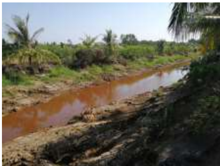
Hình 3: Đất khối trượt xuất hiện ở chân mái kênh tiêu phía đồng
