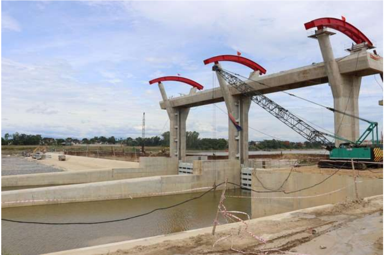
Thi công sửa chữa lớn các khoang đập phía bờ trái
