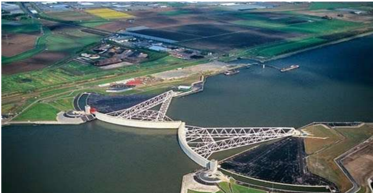
Hệ thống cống khổng lồ ngăn nước mặn xâm nhập tại tuyến đê Deltawerken. Ảnh: Deltawerken.com
