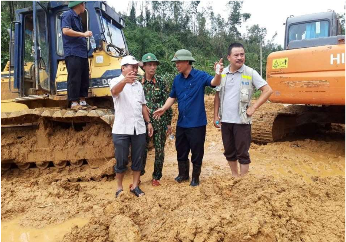
Việc đưa phương tiện cơ giới vào thủy điện Rào Trăng 3 rất khó khăn
