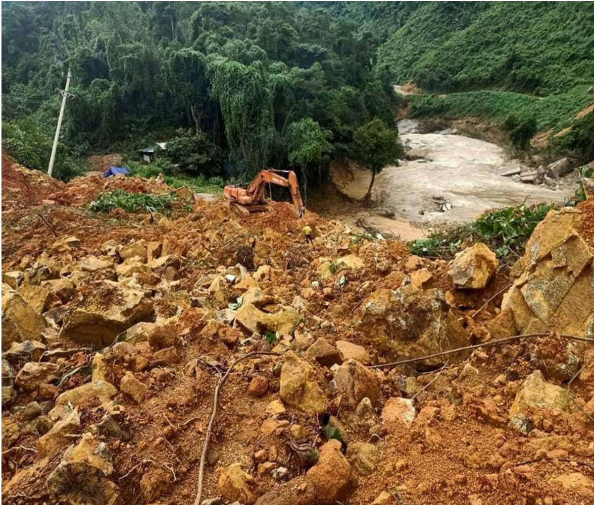
Trận sạt lở trưa 12/10 vùi lấp khu nhà điều hành thủy điện Rào Trăng 3.
