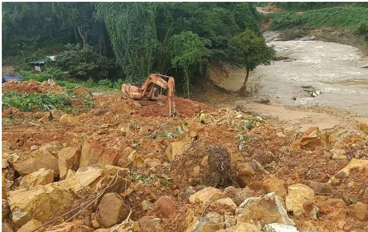
Sạt lở ở công trình thủy điện Rào Trăng 3 vùi lấp nhiều công nhân. Ảnh: Trần Hồng
