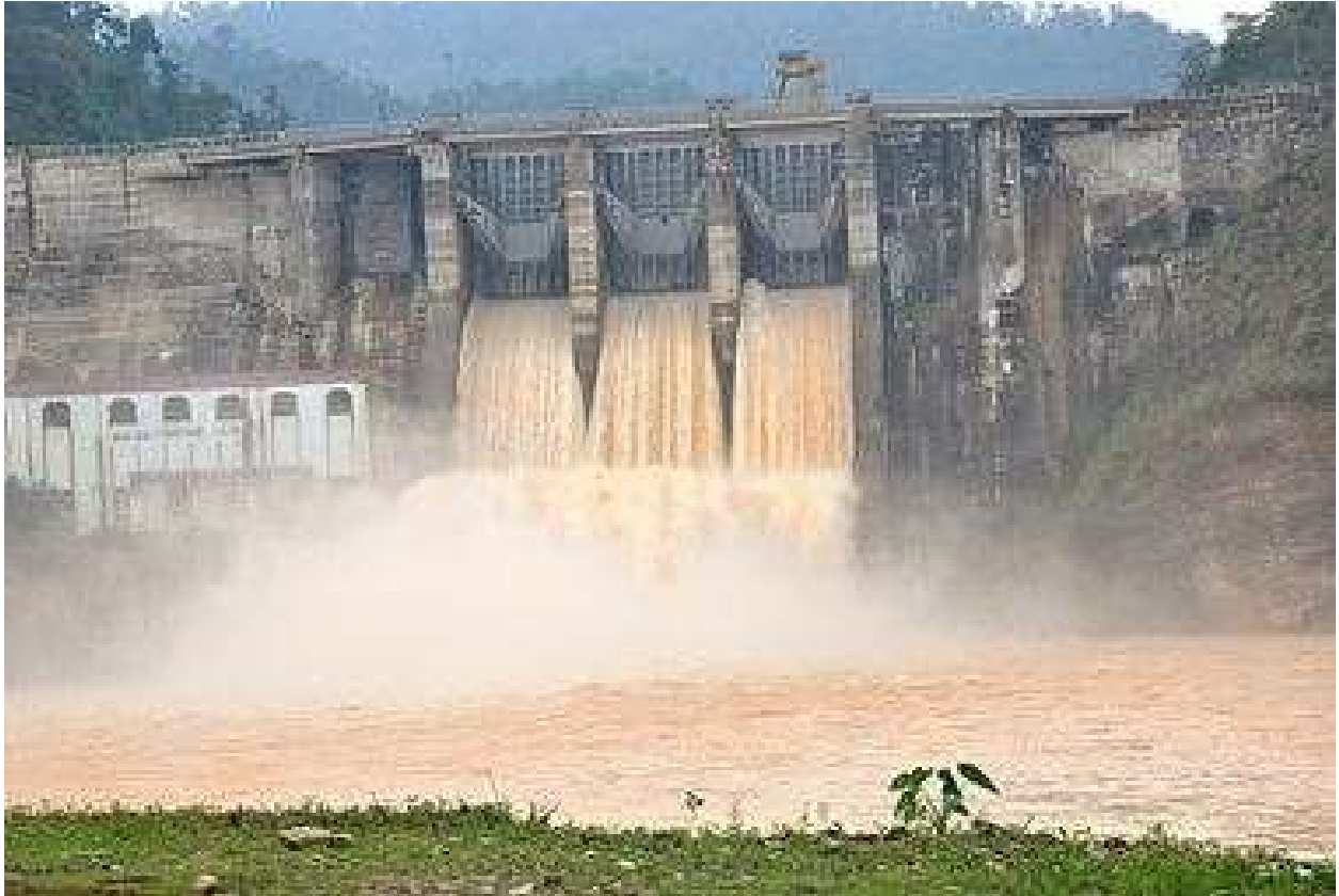
Thủy điện Hồ Hô (công ty CP thủy điện Hồ Bón), giáp ranh giữa Quảng Bình và Hà Tĩnh
