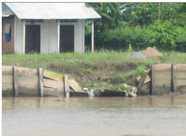
Hình 8. Các hình thức bảo vệ bờ bán kiên cố và sự hư hỏng công trình sau thời gian ngắn
