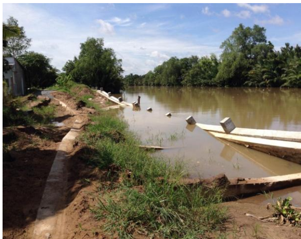
Hình 6. Hư hỏng kè mới xây dựng tại sông Bảo Định, Tiền Giang (trái) và kè sông Đồng Nai (phải)
