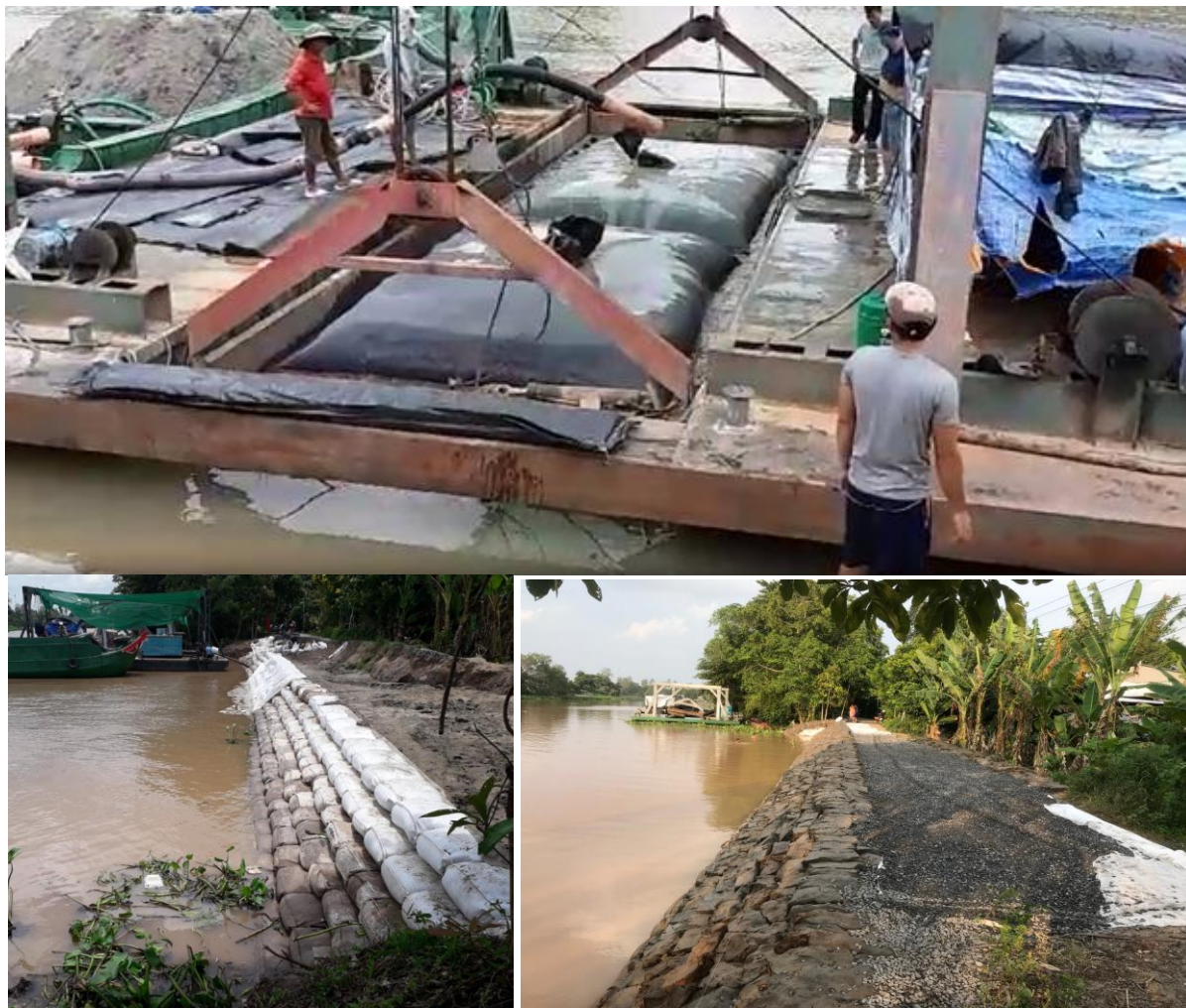
Hình 18. Đặt các bao cát lớn xử lý hố xói sâu sau đó phục hồi bờ sông và đường giao thông, công trình do Tân Đại Hưng tài trợ và do Viện đổi mới công nghệ thủy lợi mekong thiết kế và công ty giải pháp sáng tạo mekong (MKIS) thực hiện.
