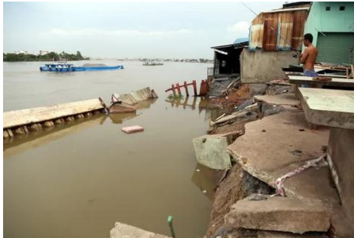
Hình 6. Hư hỏng kè mới xây dựng tại sông Bảo Định, Tiền Giang (trái) và kè sông Đồng Nai (phải)
