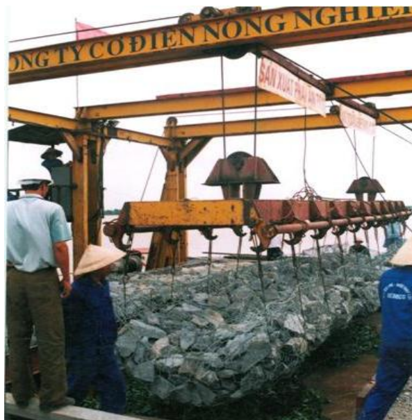
Hình 5. Thi công kè mái bằng thảm đá tại sông Tiền
