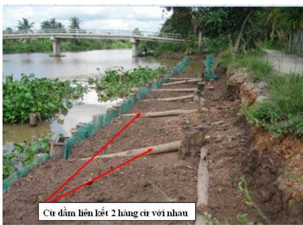
Hình 7. Gia cố bờ bằng cọc gỗ có neo (trái) và các phen cây đơn giản (phải)
