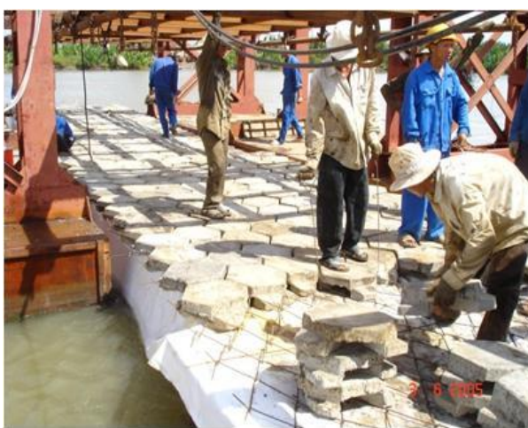
Hình 4. Tường kè bê tông dự ứng lực (trái) và Sử dụng tấm BT đúc sẵn tự chèn (phải)
