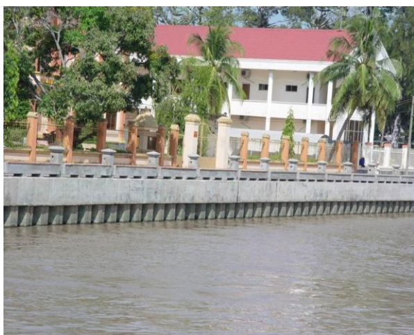
Hình 4. Tường kè bê tông dự ứng lực (trái) và Sử dụng tấm BT đúc sẵn tự chèn (phải)
