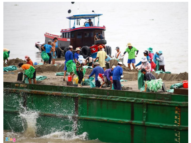
Hình 15. Lấp hố xói bằng cách thả bao cát nhỏ tại điểm sạt lở quốc lộ 91, An giang.
