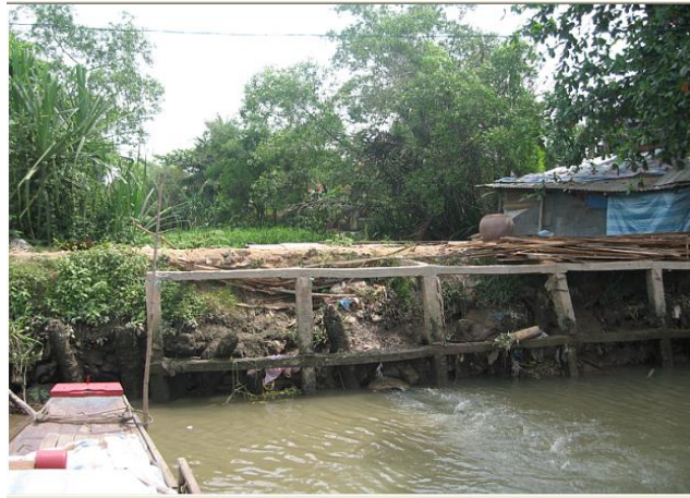
Hình 8. Các hình thức bảo vệ bờ bán kiên cố và sự hư hỏng công trình sau thời gian ngắn
