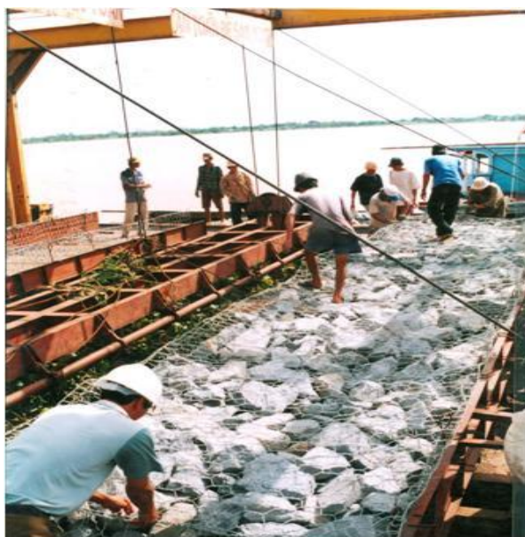
Hình 5. Thi công kè mái bằng thảm đá tại sông Tiền
