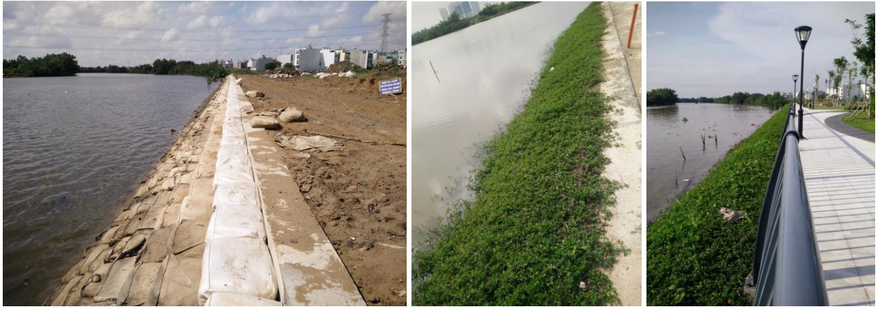
Hình 13. Kè mềm bảo vệ bờ sông khu BDS Đại Phúc, TPHCM, 2017
