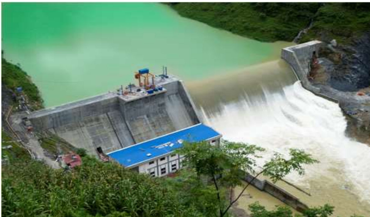
Nhà máy thủy điện 'Nho Quế 1' có công suất 32MW
