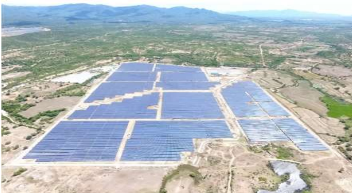
Nhà máy điện mặt trời 'Nị Hà 1' có công suất 50MW
