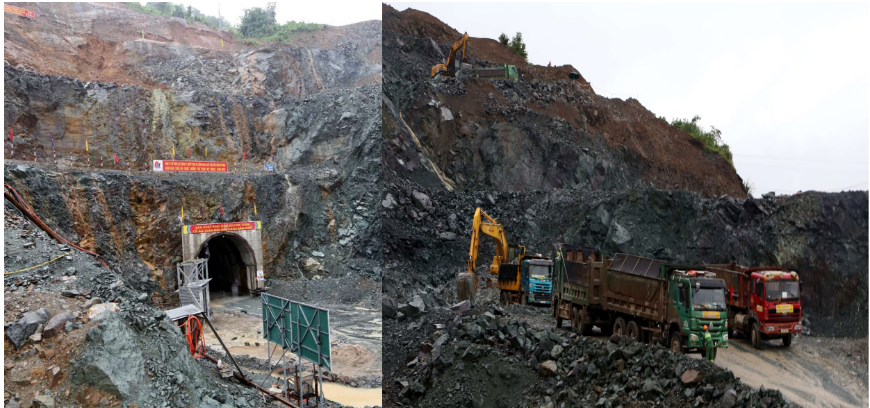
Trên công trường thi công mở rộng thủy điện Hòa Bình
