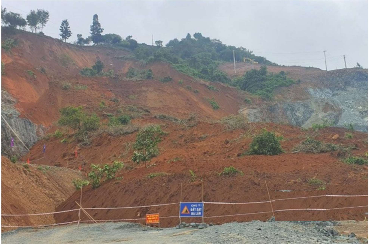
Hiện trạng khu vực sạt lở tại công trường
