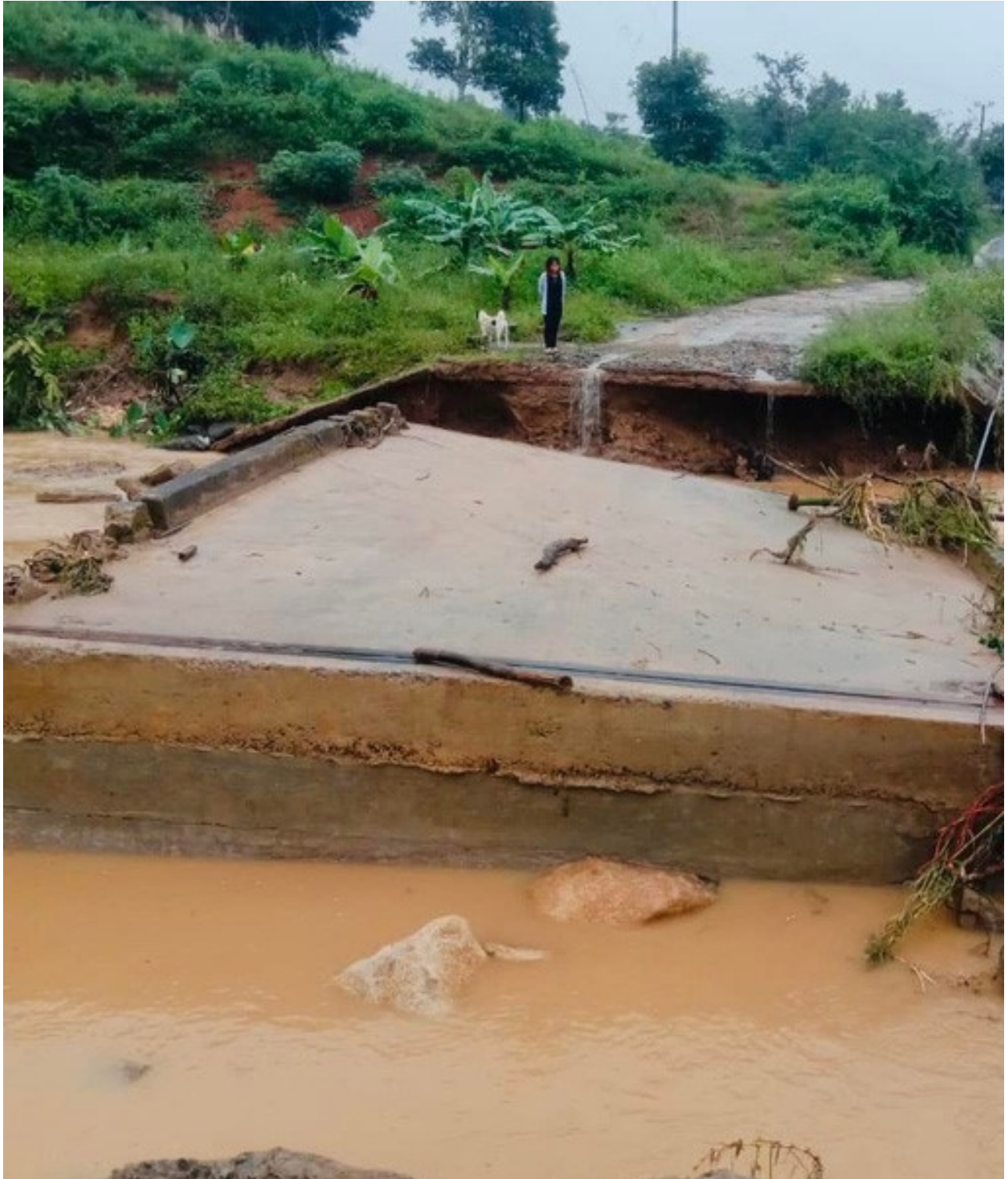
Cầu Tà Gụ (huyện Khánh Sơn) bị sập hoàn toàn sau mưa lũ . Ảnh V.N
