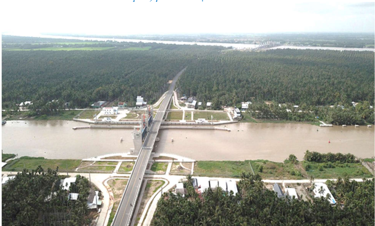
Dự án Hệ thống thủy lợi Cái Lớn - Cái Bé giai đoạn 1 (nhìn từ trên cao)
