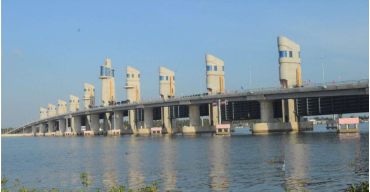
Công trình cống Cái Lớn đã hoàn thành vượt tiến độ.
