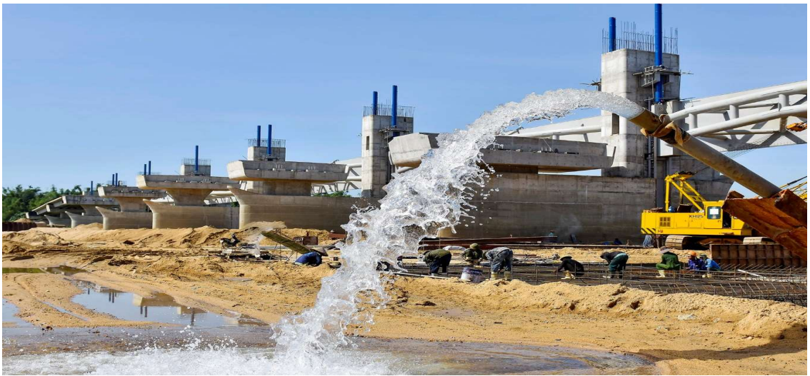
Toàn cảnh công trường hiện nay
