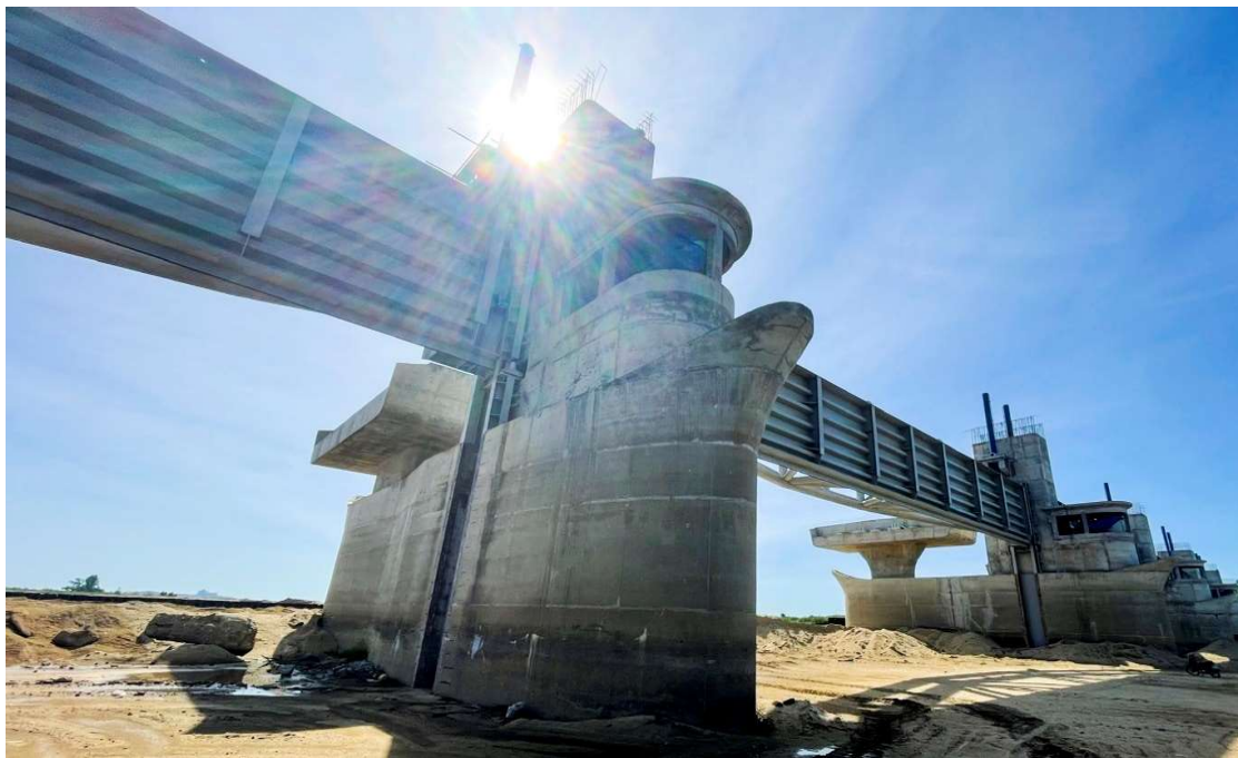
Thi công trụ đập
