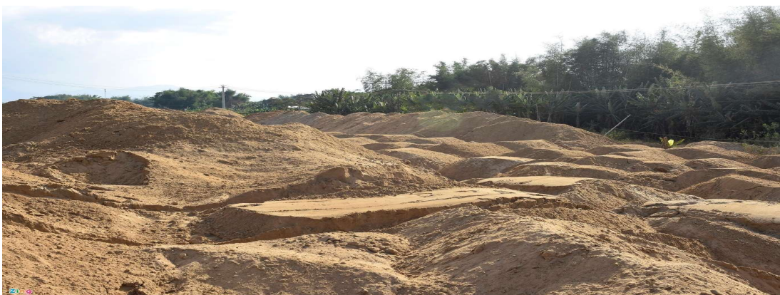
Bãi thi công trên đảo Ngọc
