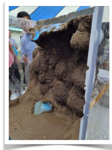
Trình diễn phụt xử lý gia cố lớp tiếp xúc giữa kết cấu bê tông và đất xung quanh
