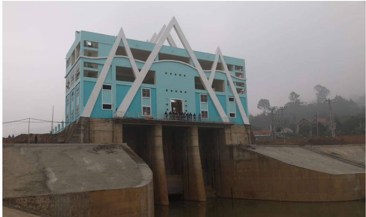
Công trình công đầu mối Lương Phú
