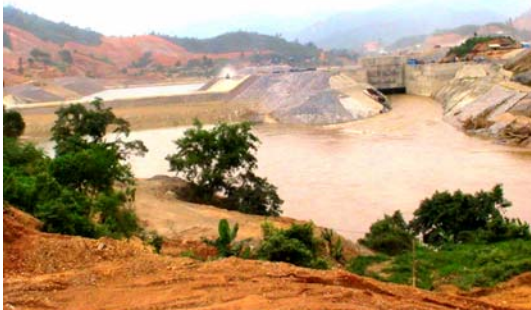
Hồ chứa nước Tuyên Quang đang xây dựng
