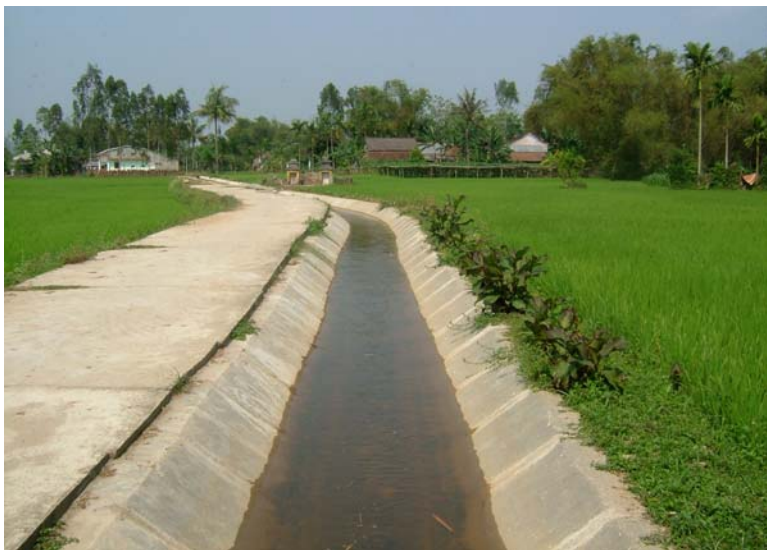
Kiên cố hoá hệ thống kênh, mương
