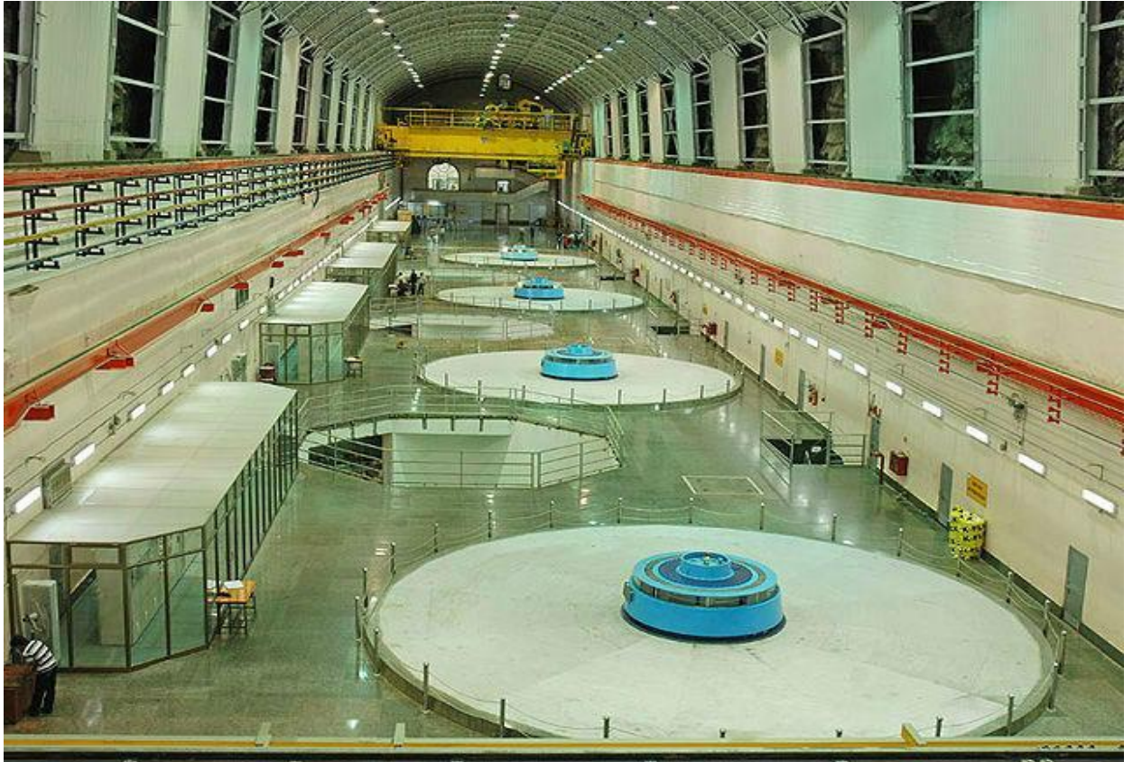
Trong nhà máy thủy điện
