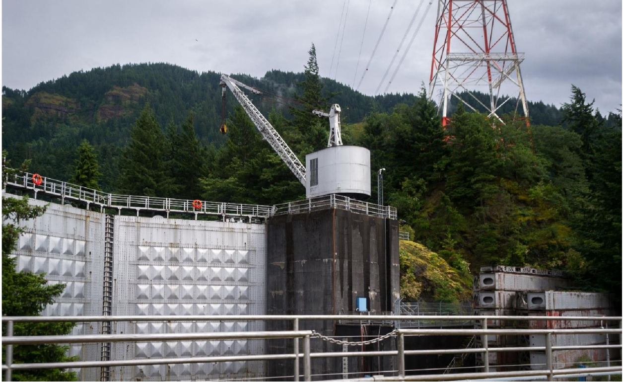
Hệ thống đóng mở cửa âu tầu
