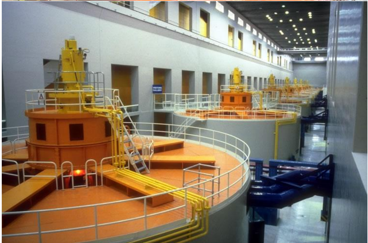
Gian máy Thủy điện 1 (ảnh trên) & Thủy điện 2 (ảnh dưới)
