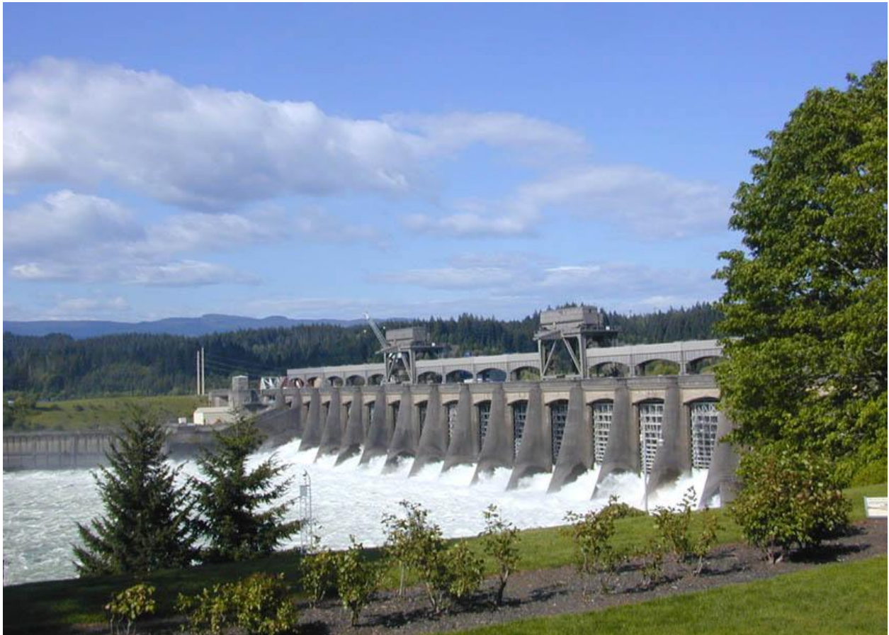
Đập tràn Bonneville, nhìn từ hạ du
