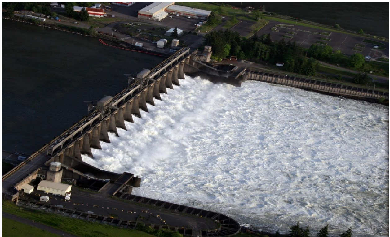
Đập tràn Bonneville, nhìn từ trên cao
