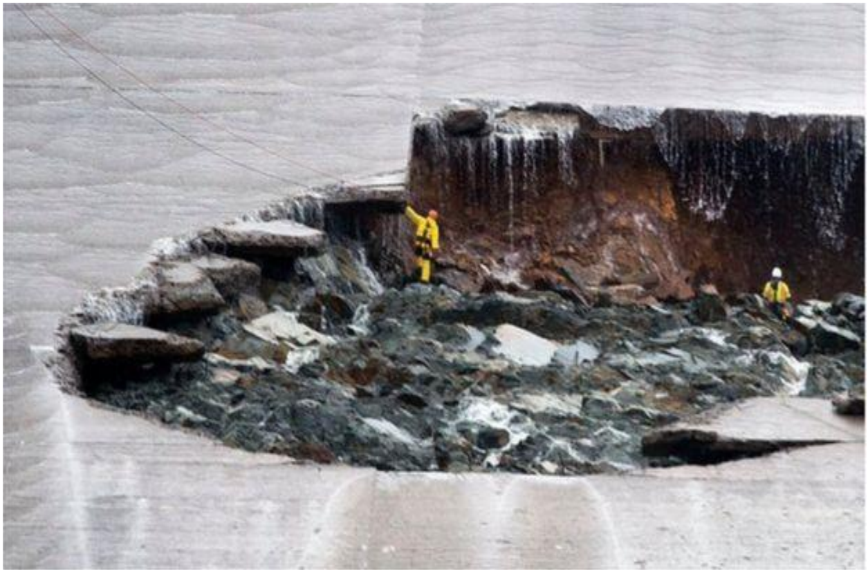
Đường tràn bị phá, tạo ra hố lớn
