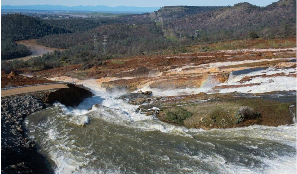
Trên tuyến tràn khẩn cấp
