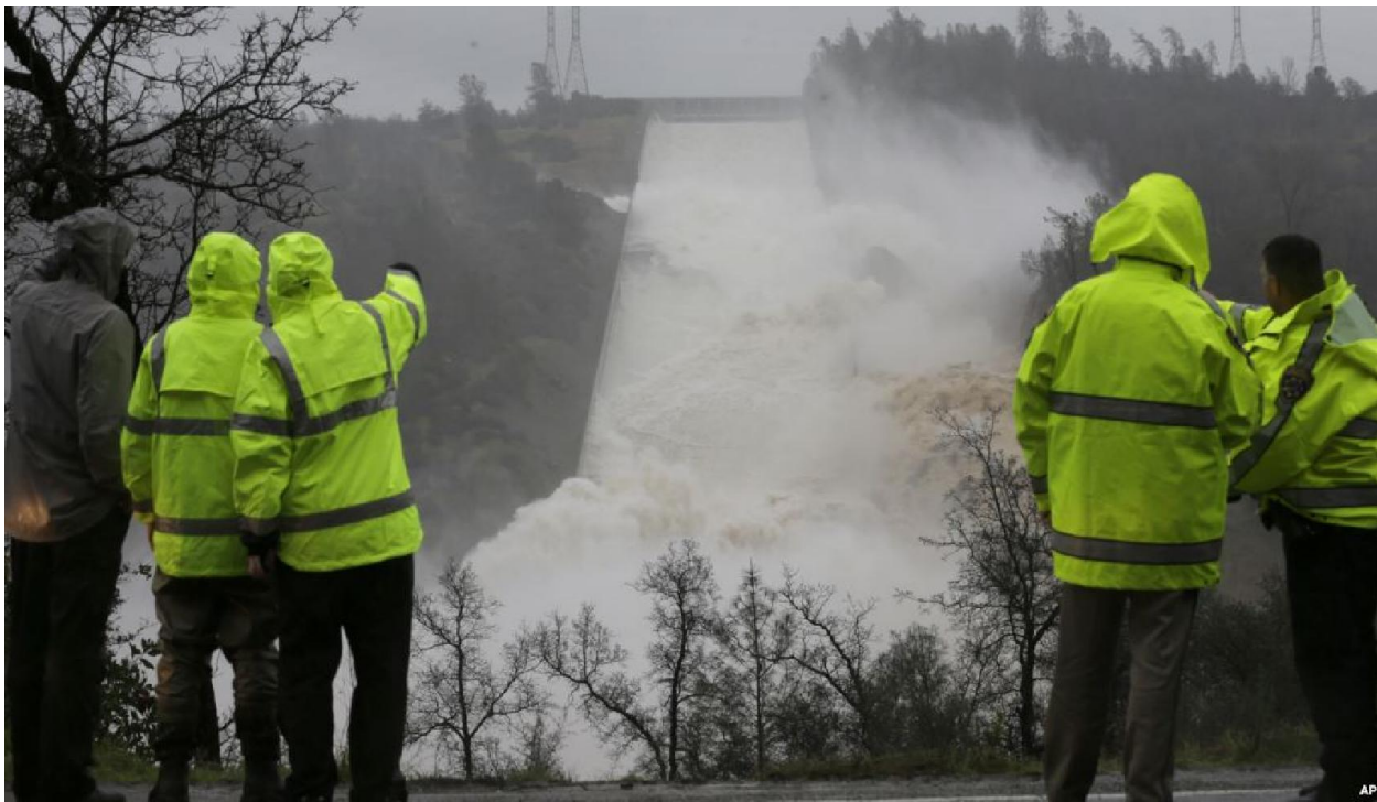
Quang cảnh đường tràn bị hư hại
