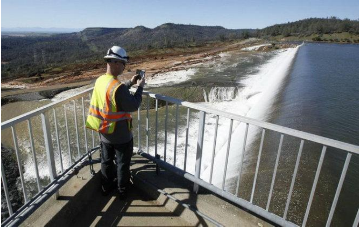
Nước lũ ào qua đỉnh tràn khẩn cấp
