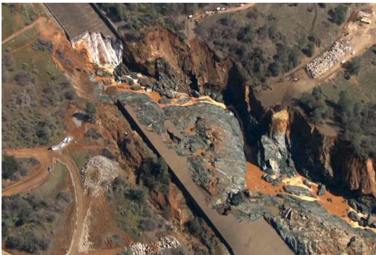
Lũ xoáy vào vùng tràn bị vỡ và xói thành hẻm sâu về hạ du (ảnh trên) và cảnh tượng sau lũ (ảnh dưới)
