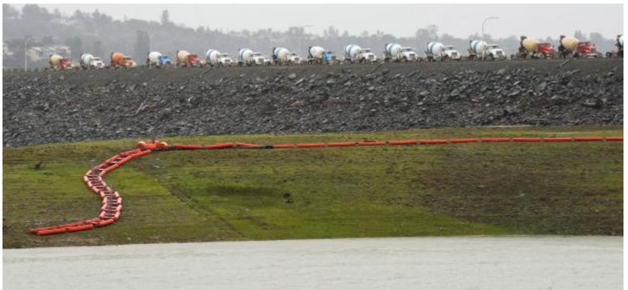
Chuẩn bị phụt bê tông cho đập chính trong tình huống khẩn cấp
