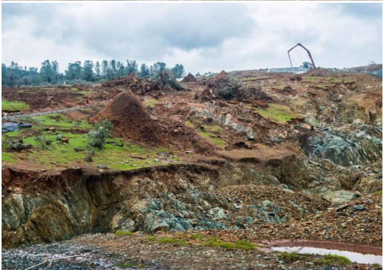
Vùng hạ du tràn khẩn cấp sau khi lũ tràn qua
