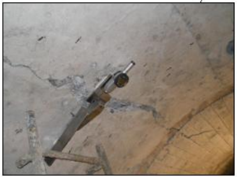
Fissure galerie d'accès
