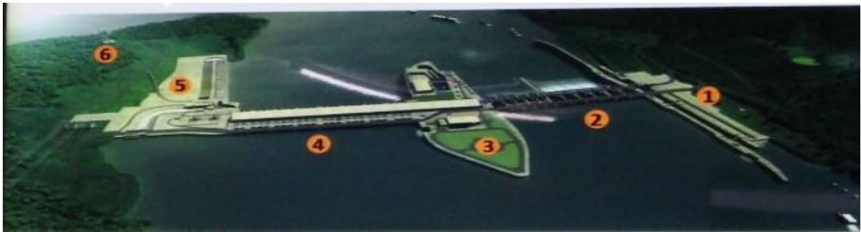
1.Ấu thuyền 2.Đường tràn + phù sa 3.Khối giữa 4.Nhà máy phát điện 5.Đường đi của cá 6.Đường tải điện
