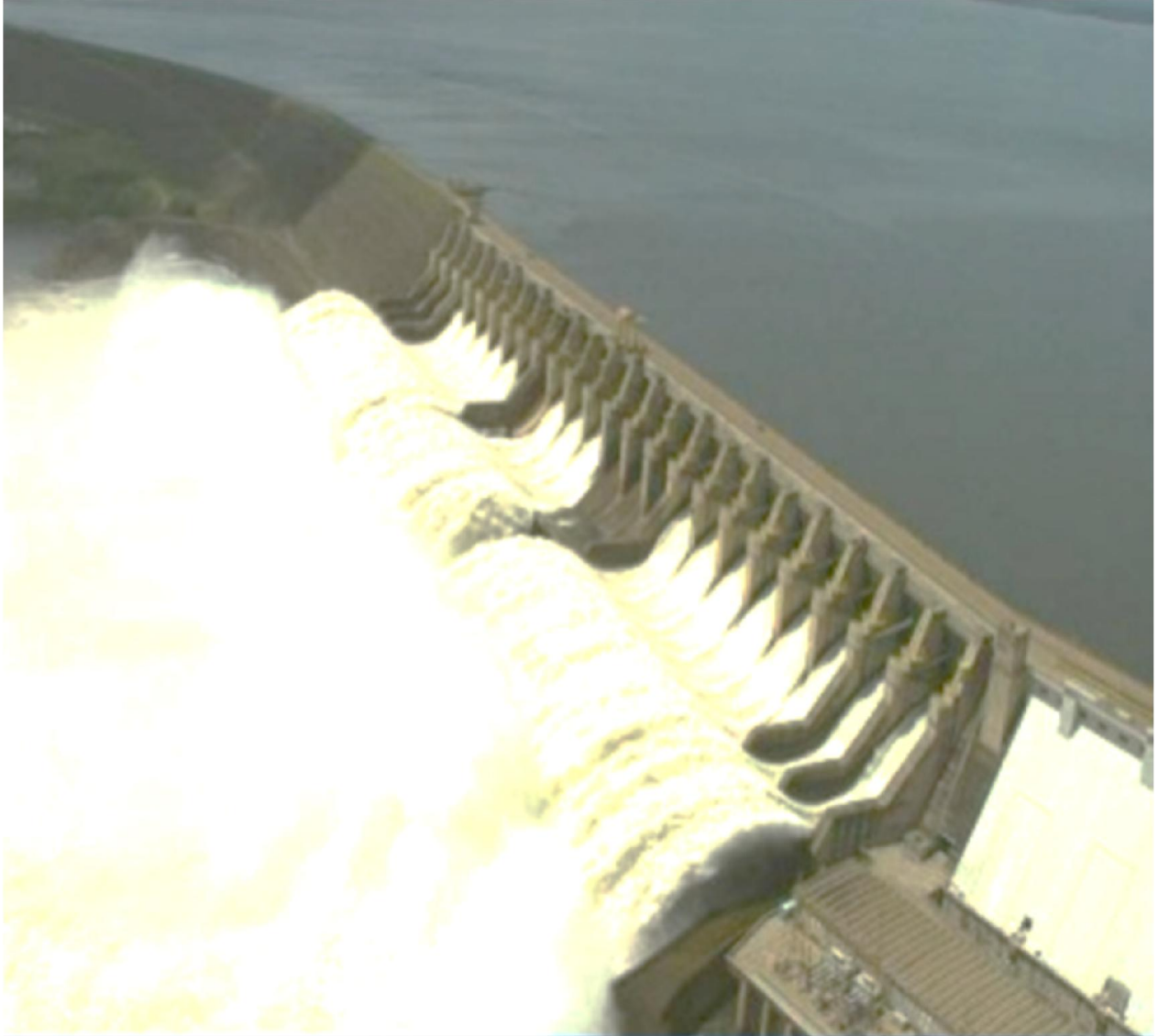
Máy ảnh toàn cảnh đập Turcuruí
