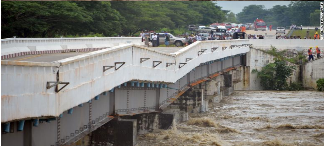
Dòng nước phá các công trình hạ tầng ở hạ du đập
