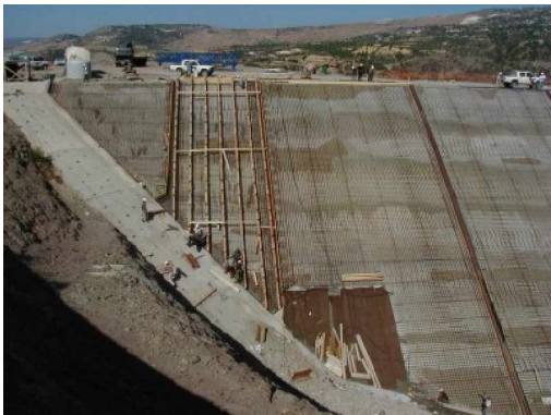
Thi công bản mặt thượng lưu bê tông cốt thép
