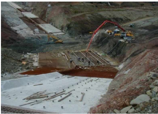
Thi công phần đế bản mặt (trái) và tràn (phải)
