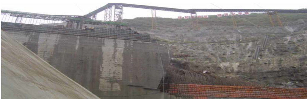
Hệ thống chuyên vận vật liệu bê tông trên cao
