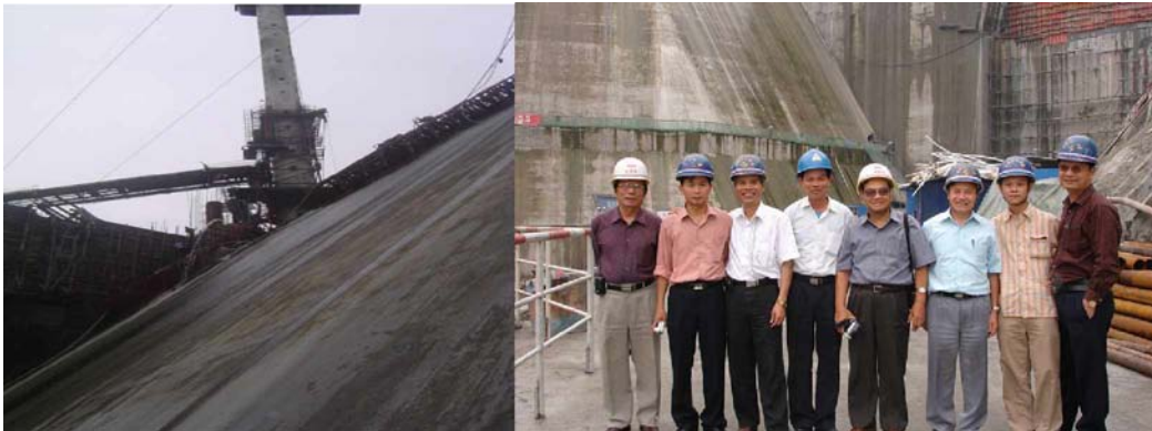
Thi công mái đập
