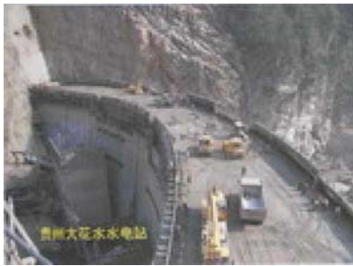
Đầu năm 2007: Đạt cao trình đập giai đoạn 1
