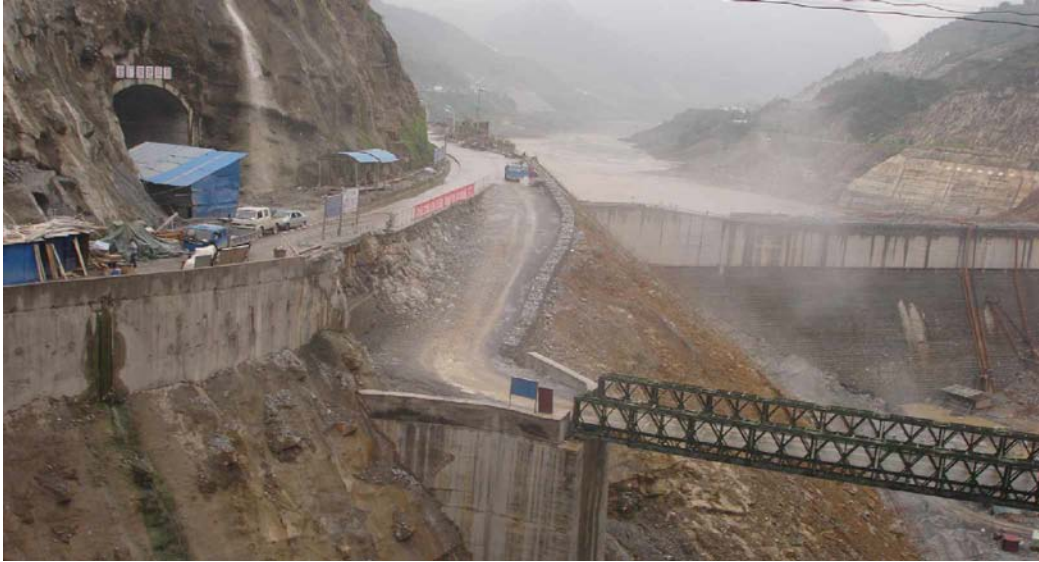
Đường vào công trường
