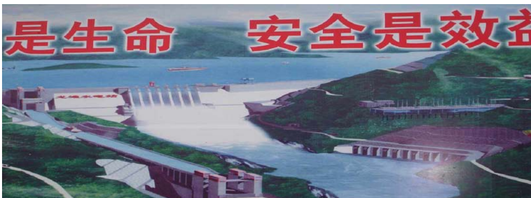
Hình toàn cảnh đập, nhà máy thủy điện, âu tàu...
