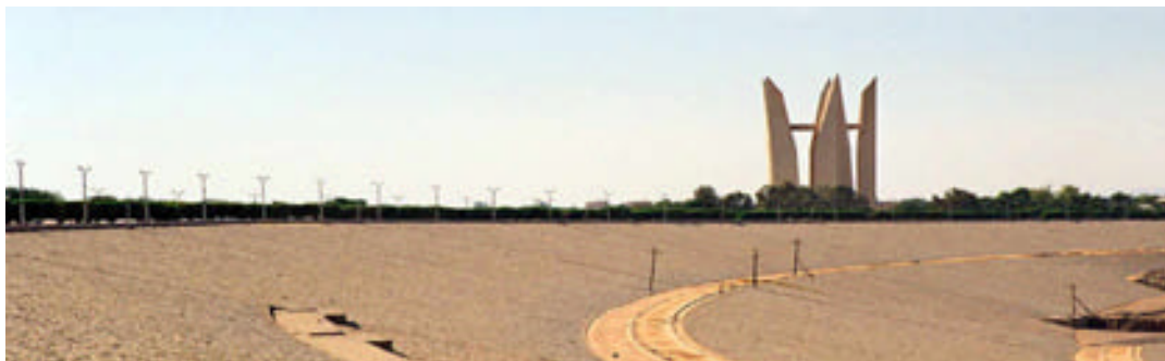
Mái hạ lưu đập
