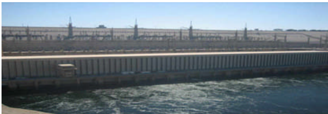
Nhà máy thủy điện
