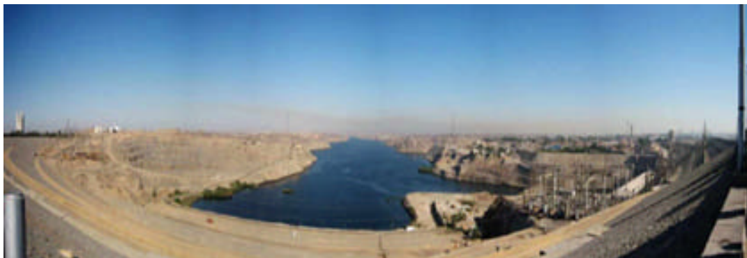
Từ đập nhìn về hạ du
