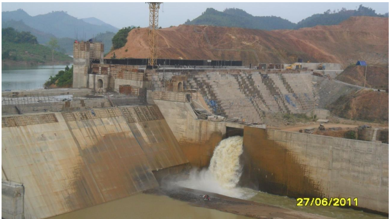
Mái hạ lưu đập, phía trái là phần đập tràn
