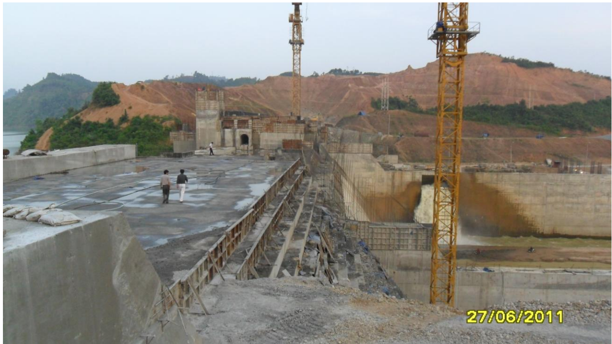
Mặt đập bên vai phải đang thi công
