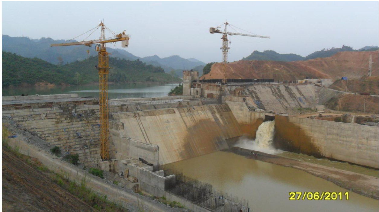
Công trường đập, nhìn từ hạ du
