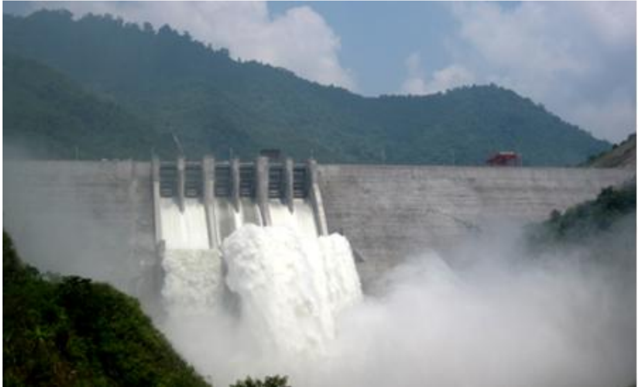
Đã hoàn thành và đang xả lũ
