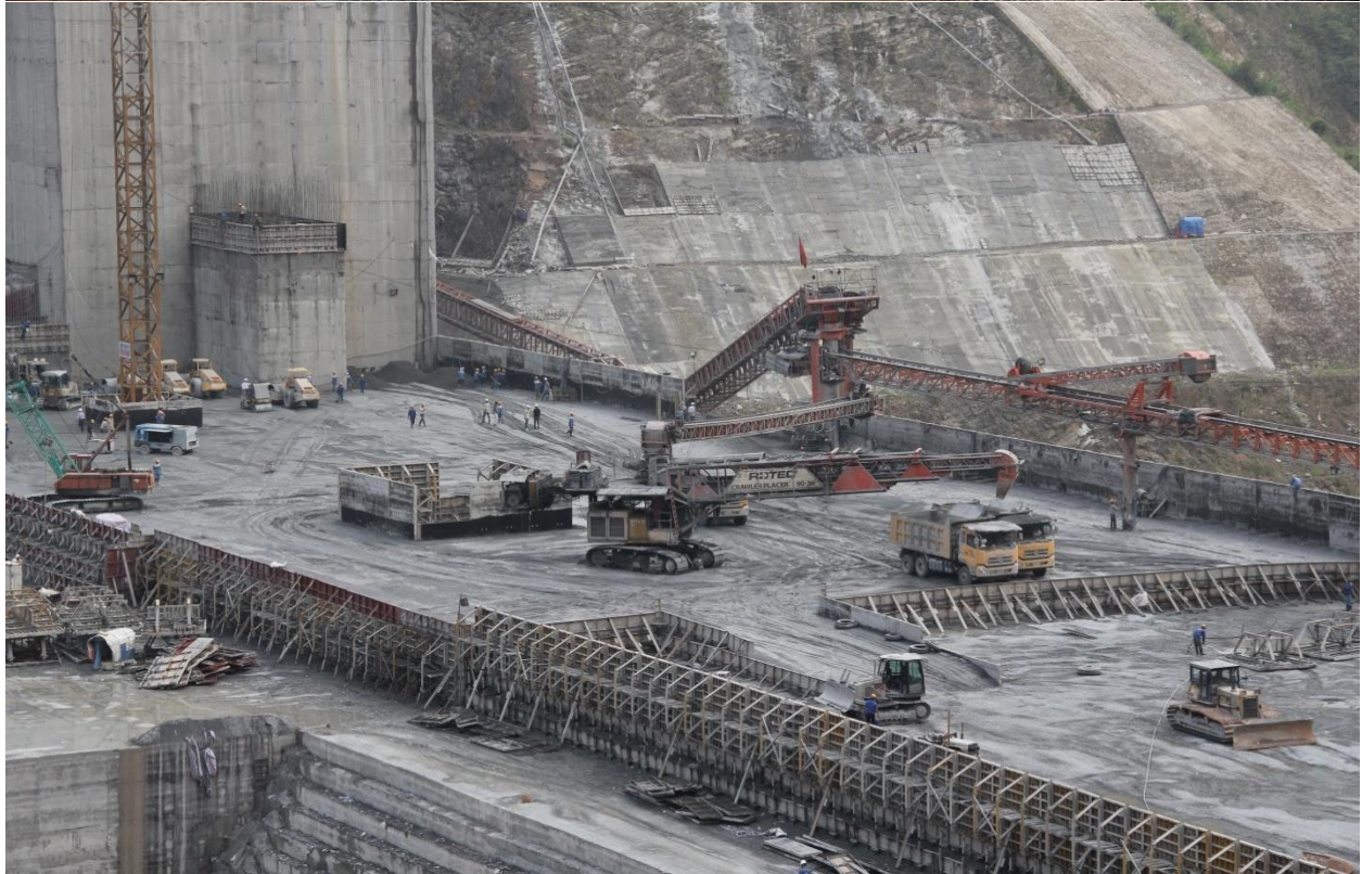
Lúc thi công
