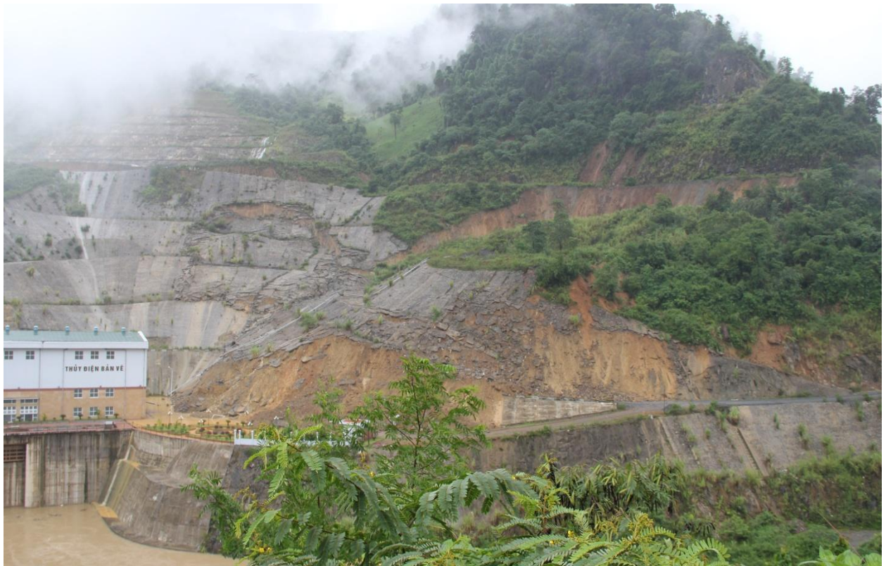
Nhà máy thủy điện bên vai đập
