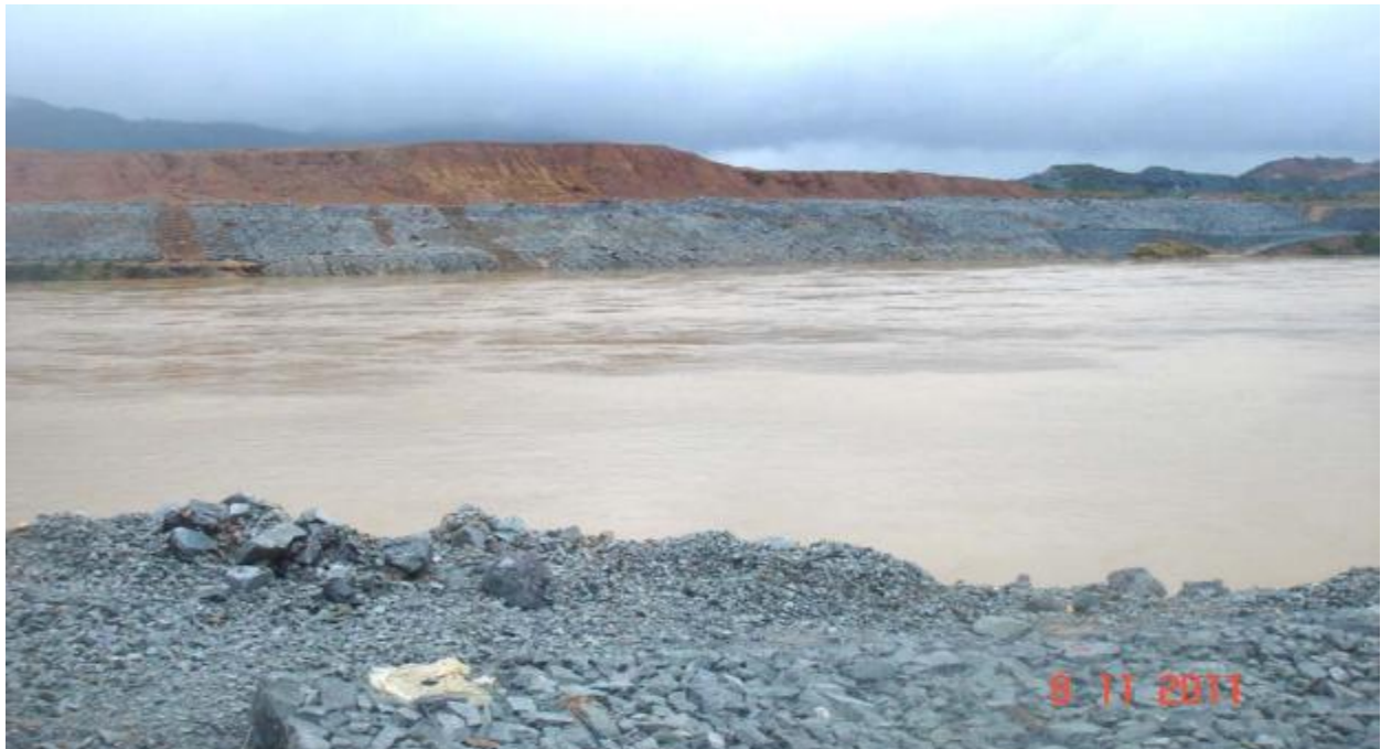
Đập chính đang thi công được gia cố không bị xói lở khi dòng lũ chảy qua
