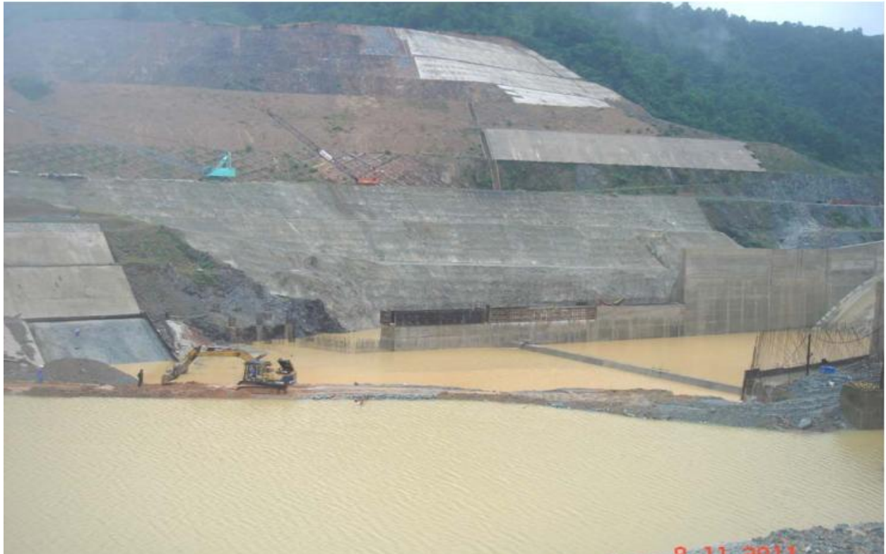
Đê hướng dòng được tôn cao và đắp trạch ngăn nước tràn
