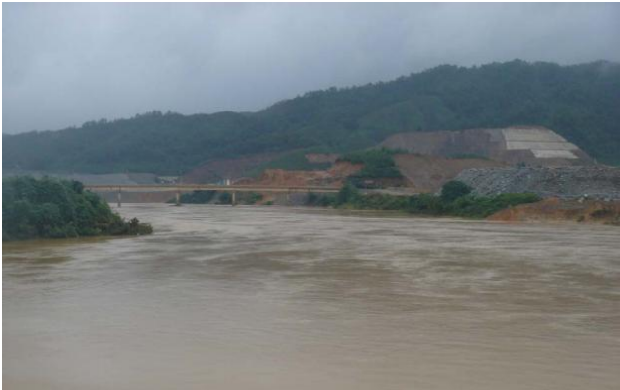
Lũ lớn hơn năm 2010 nhưng mức lũ vẫn thấp hơn 6,5m so với đê quai tràn xả lũ
