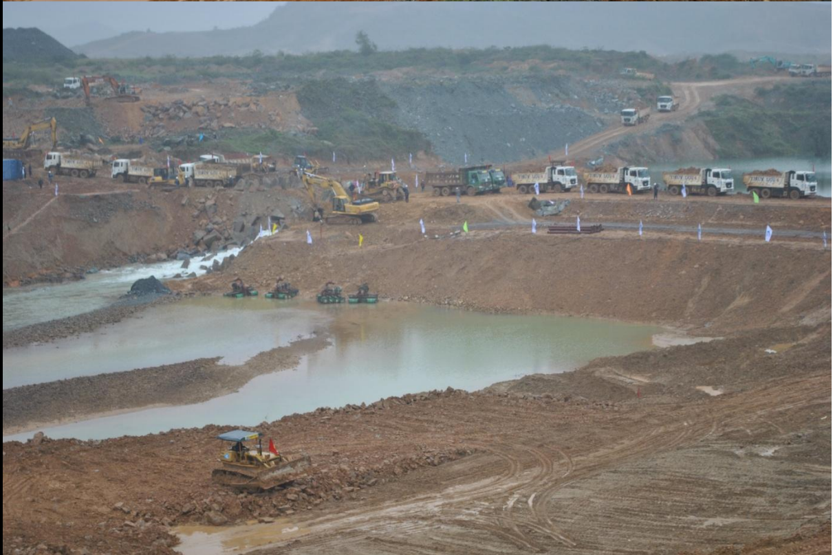
Từng đoàn xe liên tiếp chuyển đất, đá, khối bê tông đến vị trí lắp dòng
