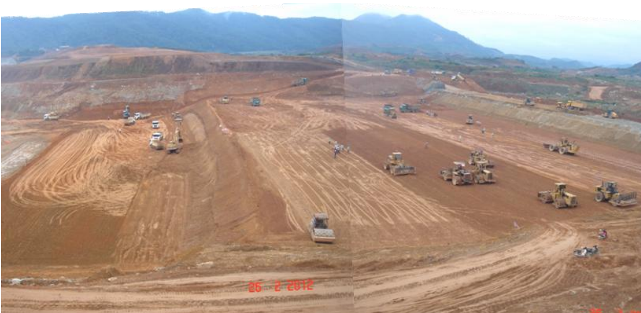
Ảnh: Toàn cảnh đập chính đoạn lòng sông (chụp 15h, 26/2/2012)
