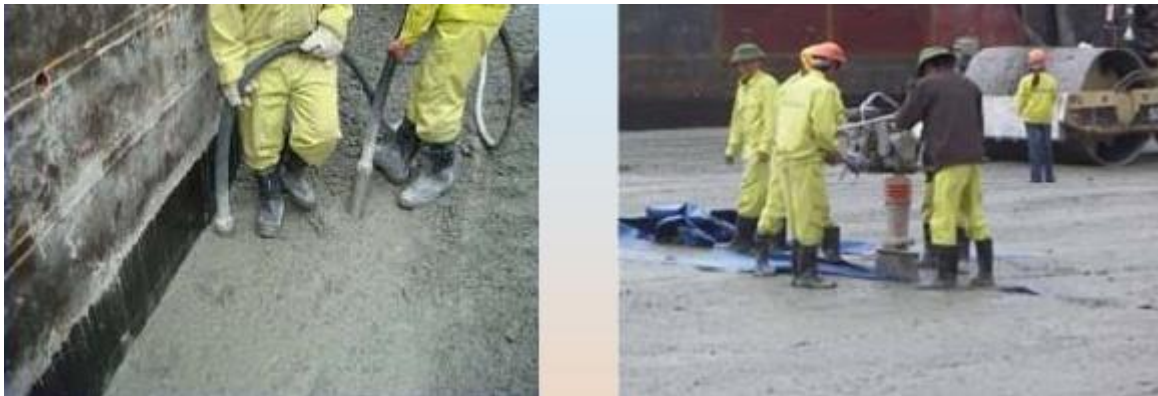
Thi công bê tông
