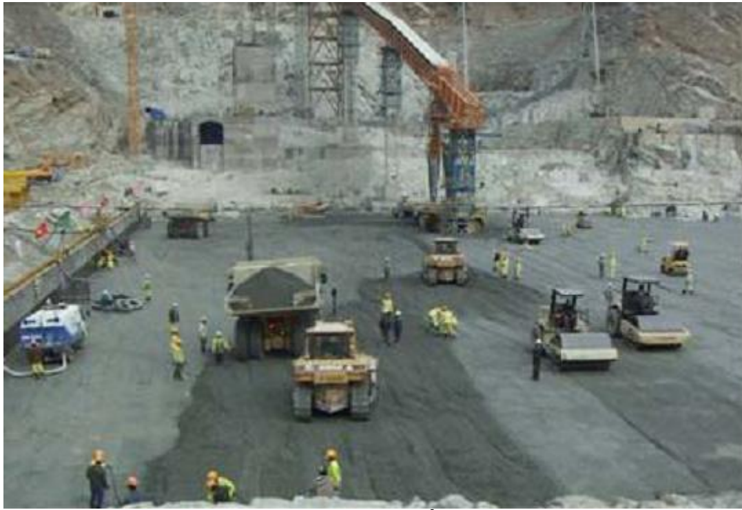
Rải bê tông và đầm lăn
