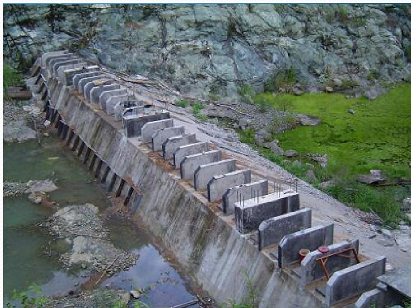
Thi công TCC 'Hộp rỗng' bê tông tại đập Saloun
