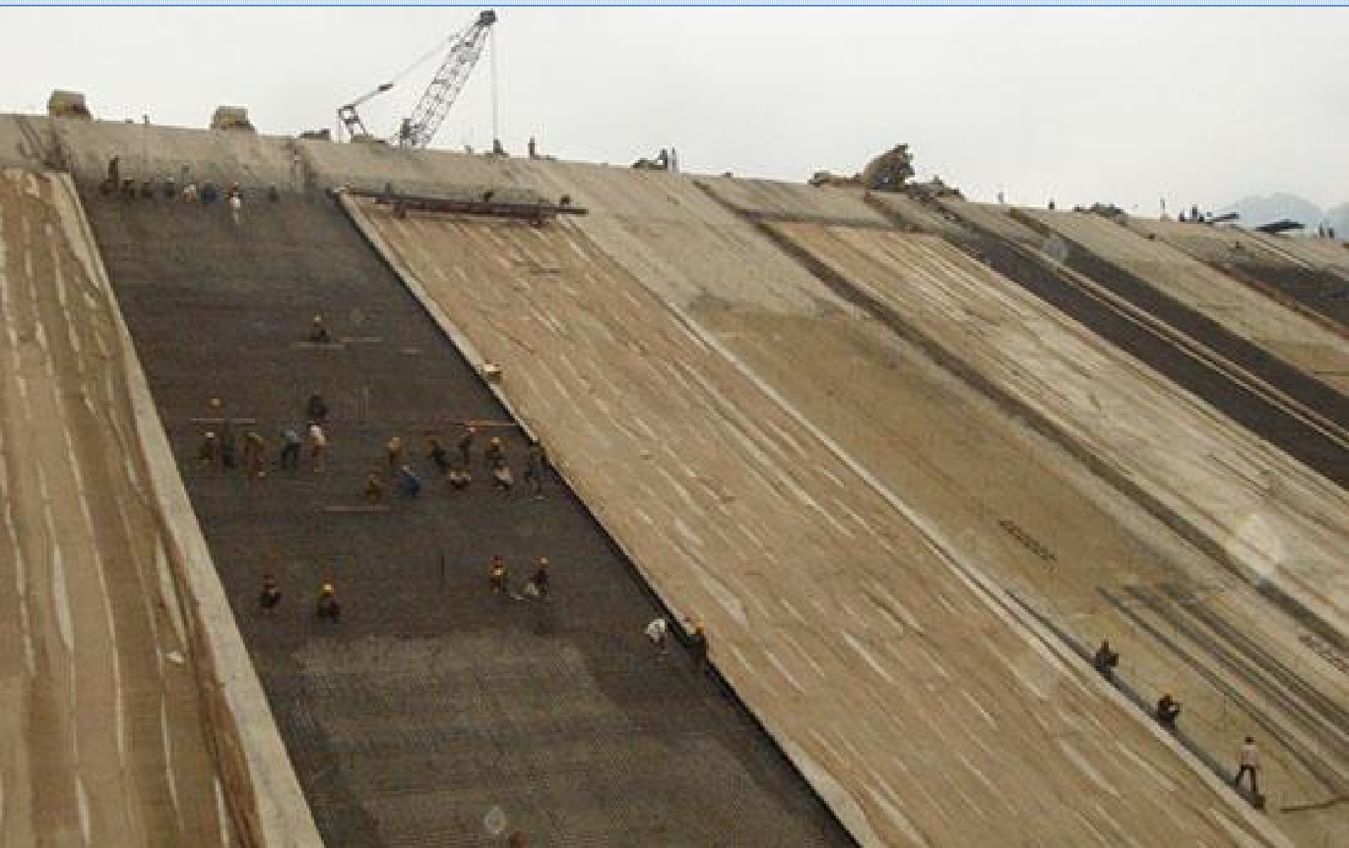
Bản mặt bê tông chống thấm ở đập chính Cửa Đạt
