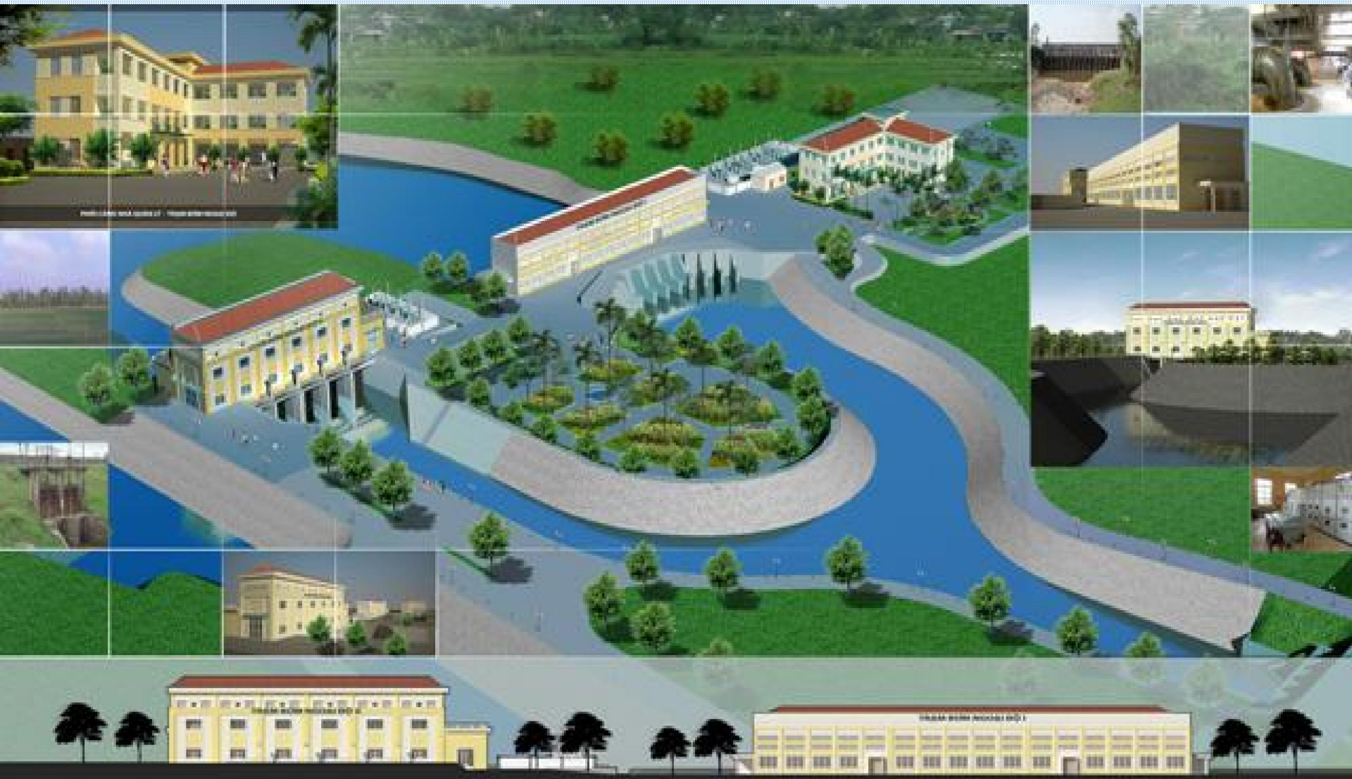
Toàn cảnh đầu mối trạm bơm Ngoại Độ 2, tiêu động lực cho 9.220 ha ra sông Đáy (5 x 22.000m 3 /h)
