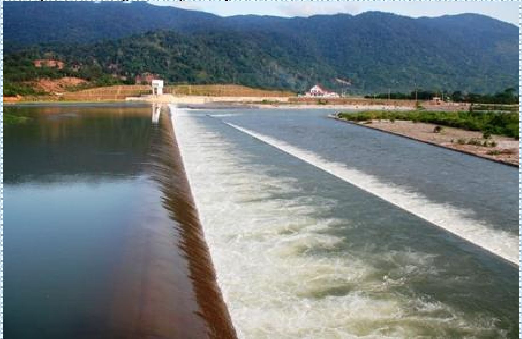
HTTL Tà Pao tỉnh Bình Thuận (đã xong đầu mối, cần đầu tư và hoàn thiện hệ thống kênh)
