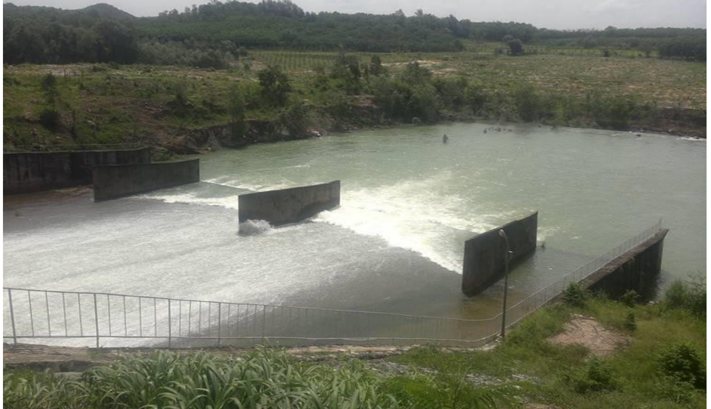
Công trình mũi phun tràn xả lũ Hồ chứa nước Kè Gỗ - Dự án WB3
