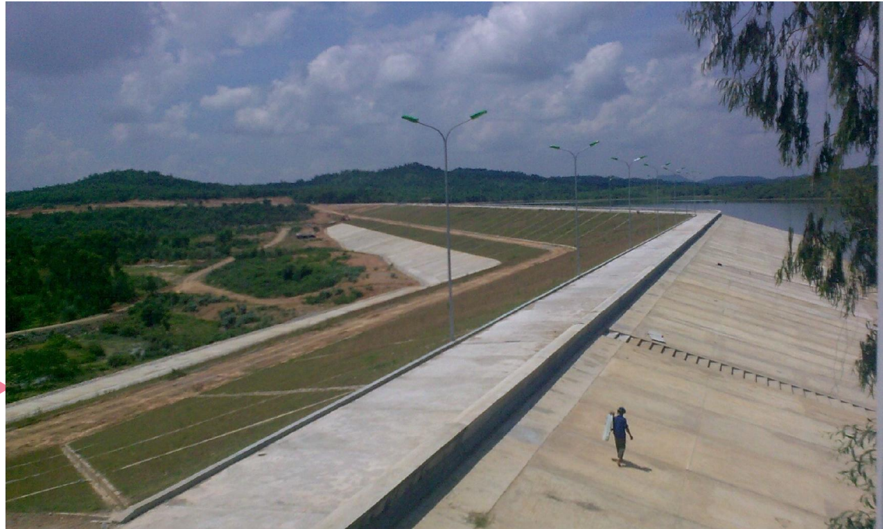
Công trình thượng lưu đập Vực Mầu - Dự án ADB4
