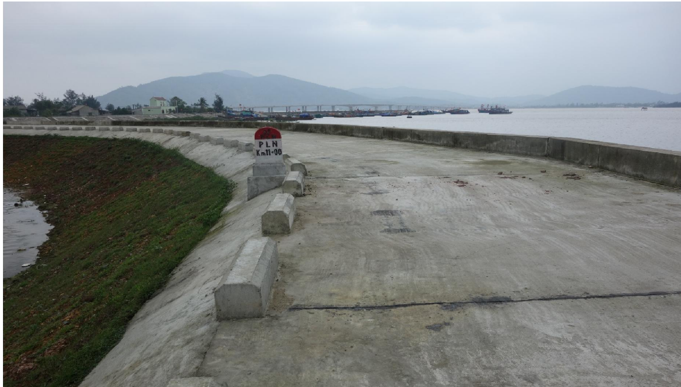
Công trình đê Phúc Long Nhượng - Dự án WB5
