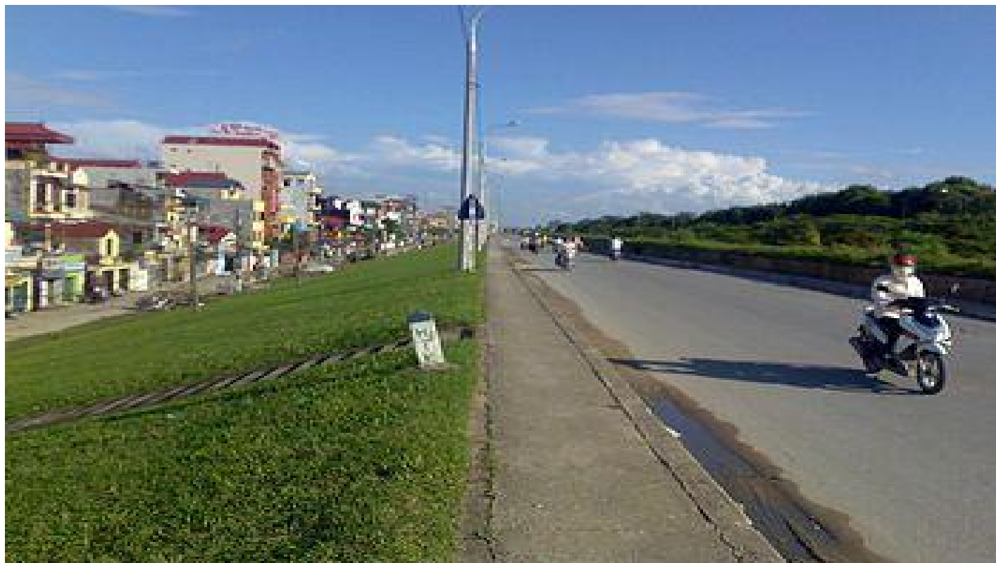
Công trình đê sông Hồng (Hà Nội) – Dự án ADB1
