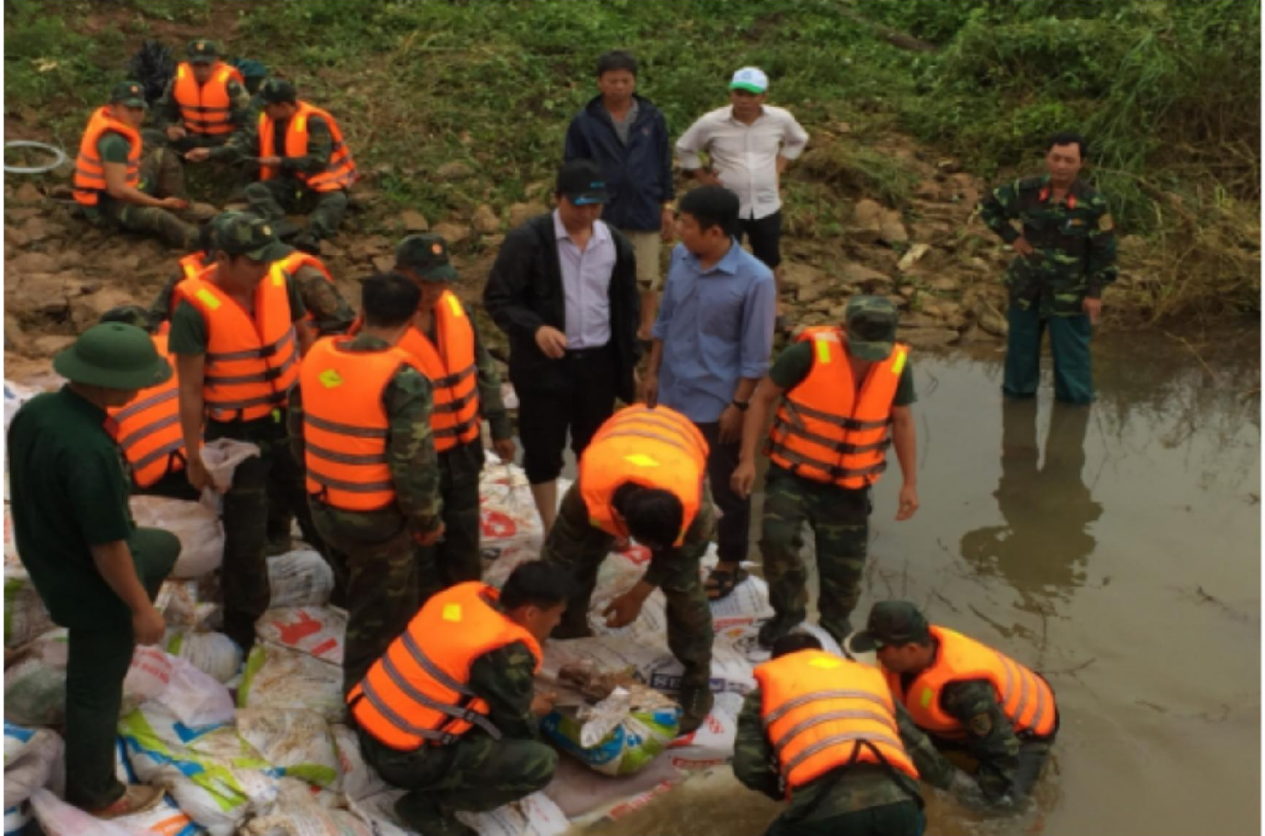
Vụ trưởng Quản lý Công trình Thủy lợi Đồng Văn Tự hướng dẫn bộ đội công binh tại hiện trường.
