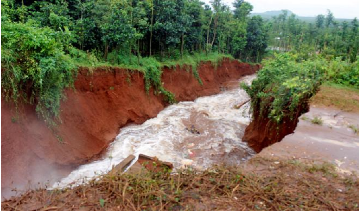
Dòng nước cuộn cuộn từ bờ tràn bị phá
