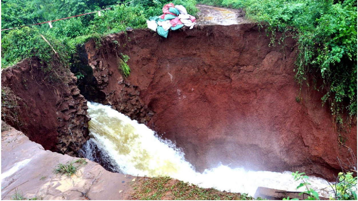
Phần thân đập Gia Hoét bị vỡ
