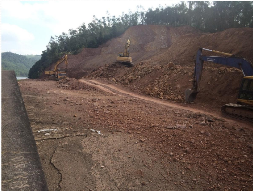
Thi công hồ Khe Chè, tỉnh Quảng Ninh – một trong 12 tiểu dự án năm đầu, dự án WB8
