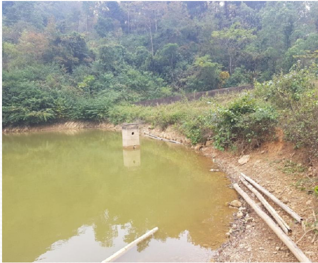
Hồ Na Lặp, tỉnh Lạng Sơn có mái đập chưa được gia cố, cống lấy nước tạm
