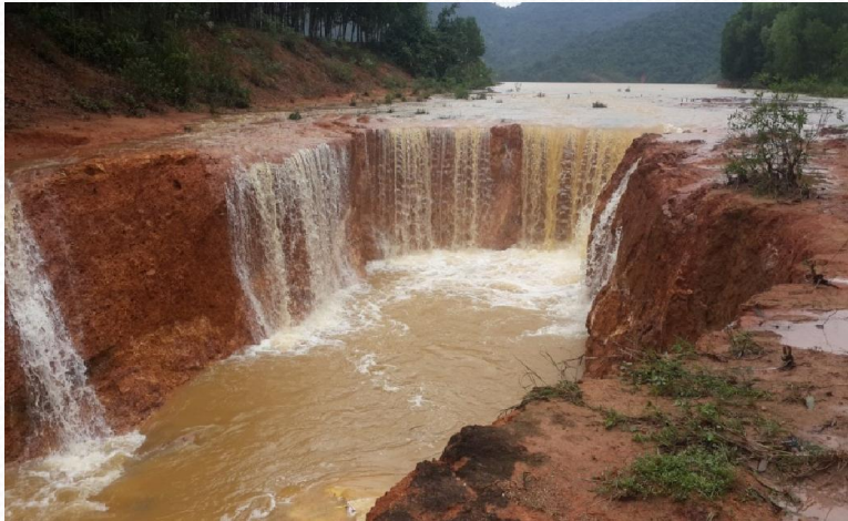
Tràn xả lũ hồ Hóc Sấu, tỉnh Bình Định bị sự cố năm 2017
