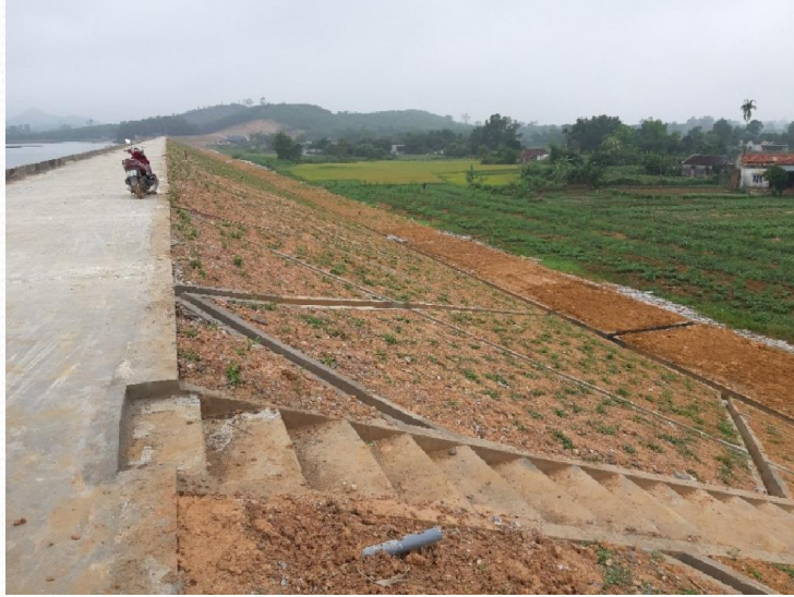
Hồ Đồng Bể, tỉnh Thanh Hóa – một trong 12 tiểu dự án năm đầu, dự án WB8 đã thi công cơ bản hoàn thành
