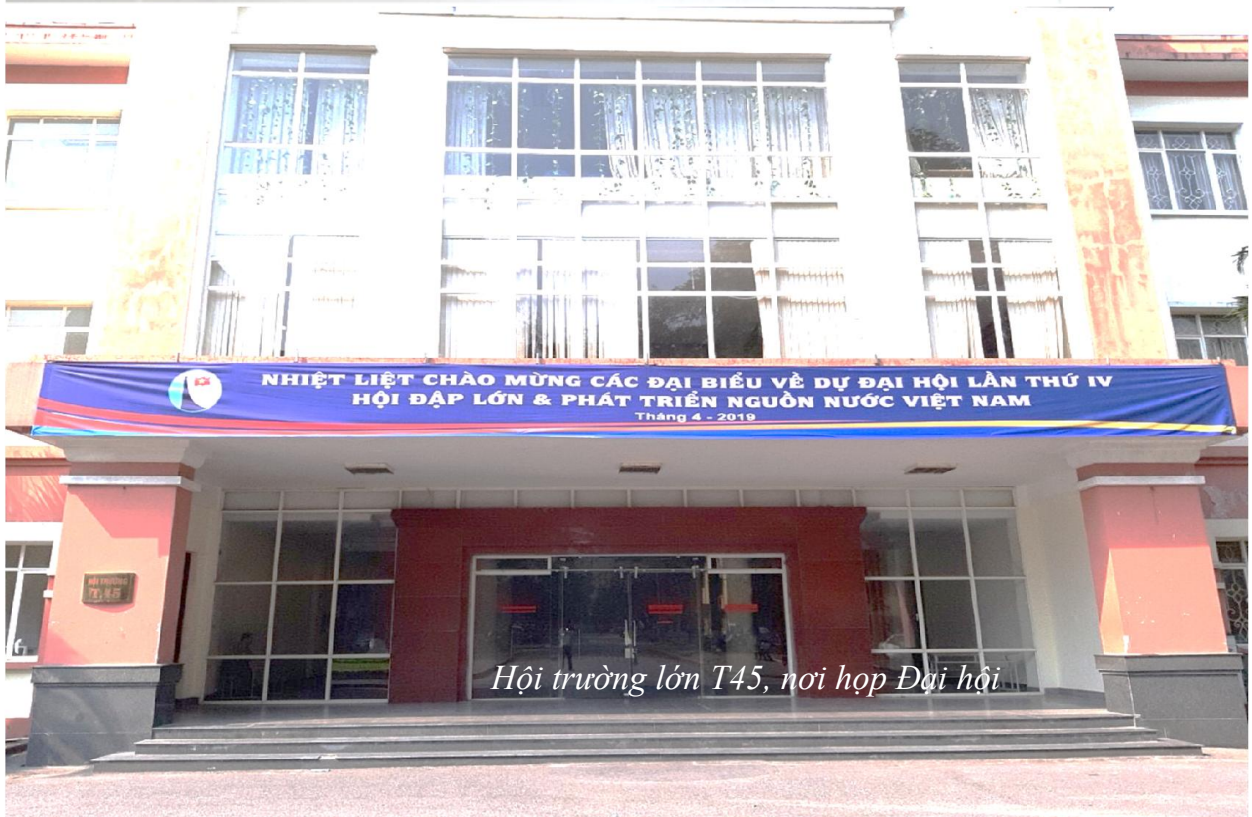
Trường Đại học Thủy lợi chuẩn bị đón các vị đại biểu
