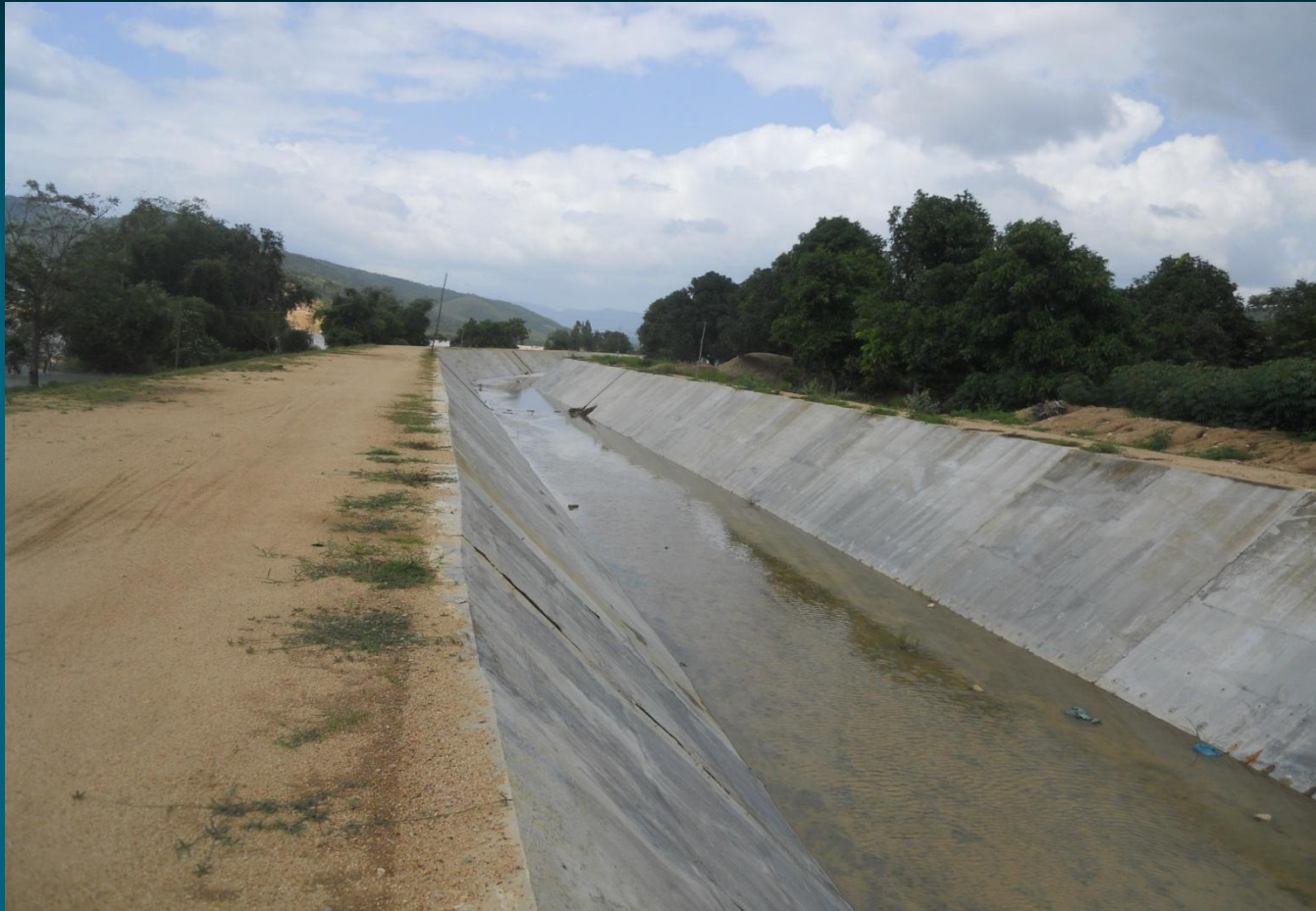
Hình 2. Kênh Văn Phong đang thi công
