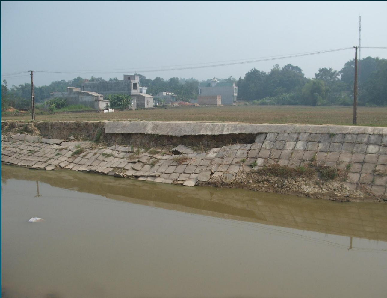
Hình 1. Mái kênh Liên sơn đã bị hư hỏng nhiều vùng
