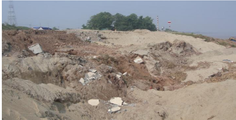
Hình 7. Hình ảnh khối trượt nhìn lên đỉnh đê hữu Hồng
