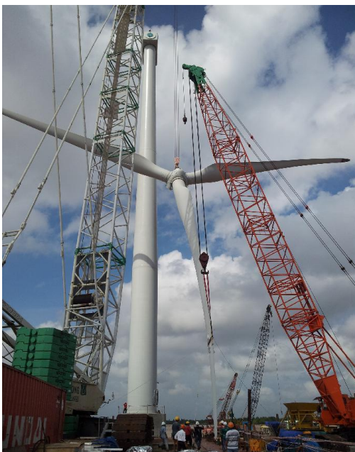
Hình 5: Lắp dựng cánh tuabin đường kính 84m
