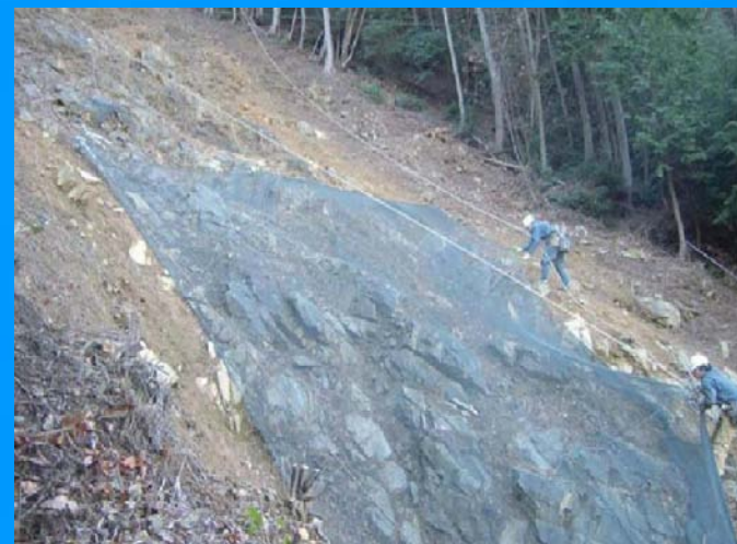
落石ネットによる斜面覆い工
