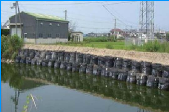
応急復旧資材 2-ton Bag
