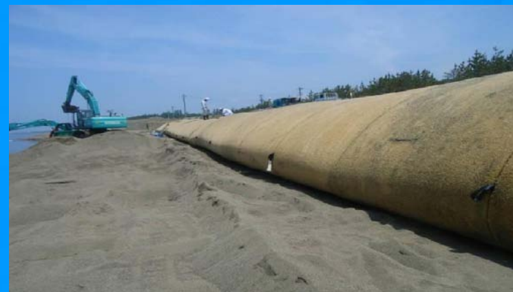
シーガーディアン 海岸浸食／浜崖防止工法
