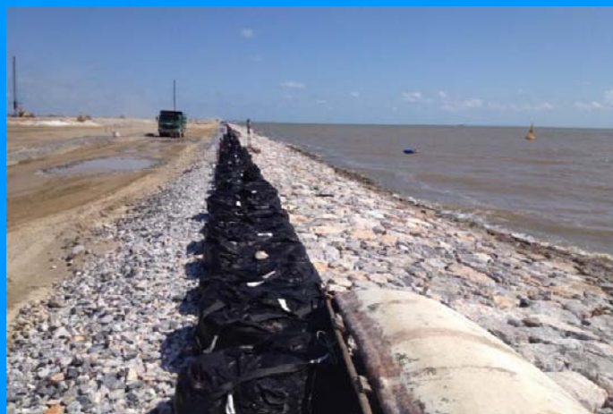
応急復旧資材 2-ton Bag
