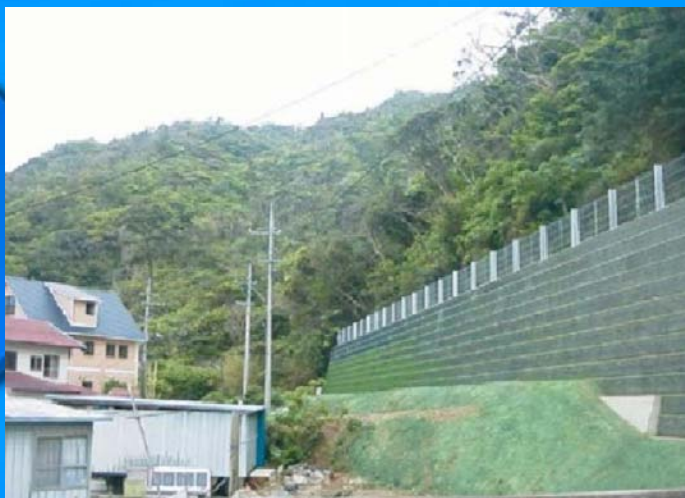
急傾斜地崩壊 / 落石対策
