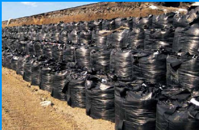
応急復旧資材 2-ton Bag
