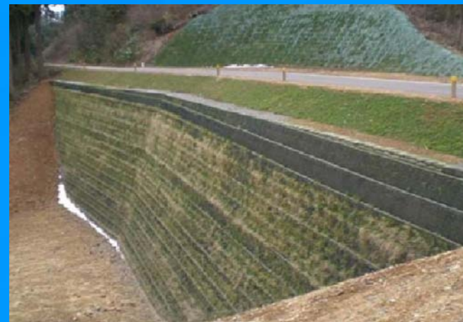
ADEAM 補強土壁工法
