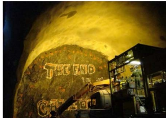
Hình 28: Một hầm đã được bơm bê tông vừa trước thành công (một đoạn hoàn chỉnh của hầm đường sắt Bærum) mà kết quả là khiến cho “99.9995” bề mặt bê tông phun là khô (không ẩm).
