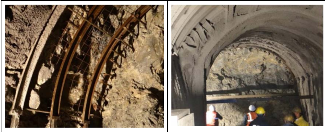
Hình 16: Bên trái: Minh họa về thách thức của việc tạo tiếp xúc tốt giữa biên đào và các vòm chống thép, ngay cả trong trường hợp có đào lẹm hạn chế. Trong NATM, các vòm chống thép “được phun phủ bê tông”, cùng S(mr) và neo đá được xem là tạm thời, và không được xét đến trong thiết kế lớp vỏ hầm vĩnh cửu cuối cùng. Hình bên phải: Các khung chống thép thực sự là một kiểu chống đỡ hầm rất dễ biến dạng. Tuy nhiên, trong loại đá chịu nén ép như được minh họa, thì việc dùng RRS cũng có thể gặp khó khăn, trừ phi các bulông neo tự khoan là được dùng để neo các sườn chống RRS trong đá xấu (quá ứng suất) mà nó có thể bao quanh hầm trong những trường hợp như vậy.
