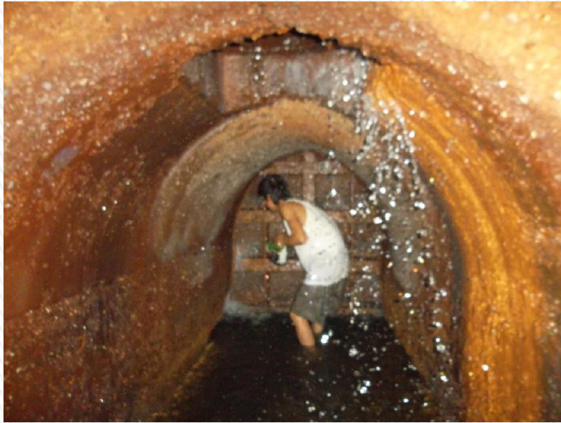
Cống lấy nước hồ Suối hai
