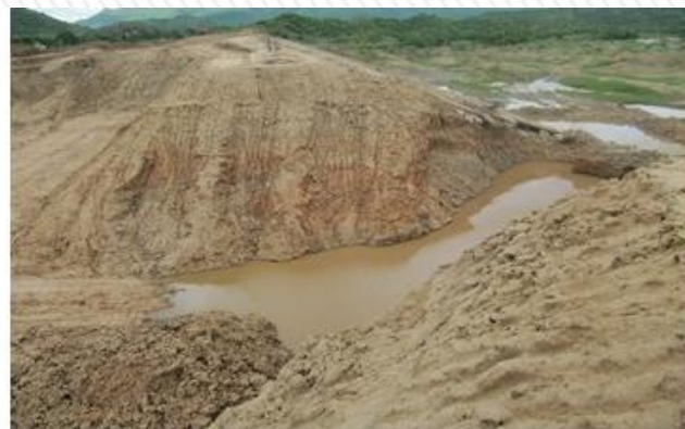
Vỡ đập đang thi công Lan Ra (Bình Thuận) năm 2011
