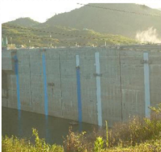
Hình 14. Phủ polyurea chống thấm Đập TĐ Sông Tranh 2
