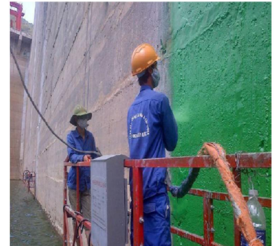
Hình 16. Phủ polyurea chống thấm Đập TĐ Bản Chát
