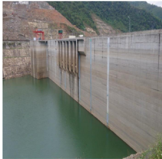
Hình 15. Phủ polyurea chống thấm Đập TĐ Bản Vẽ
