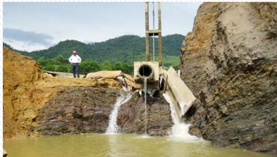
Vỡ đập Z20 –Hà Tĩnh 2009
