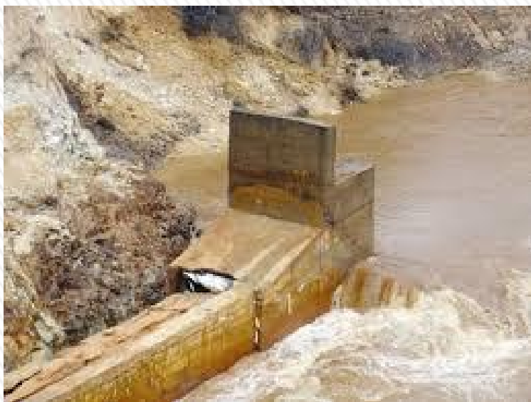
Đập thủy điện IaKrel2
