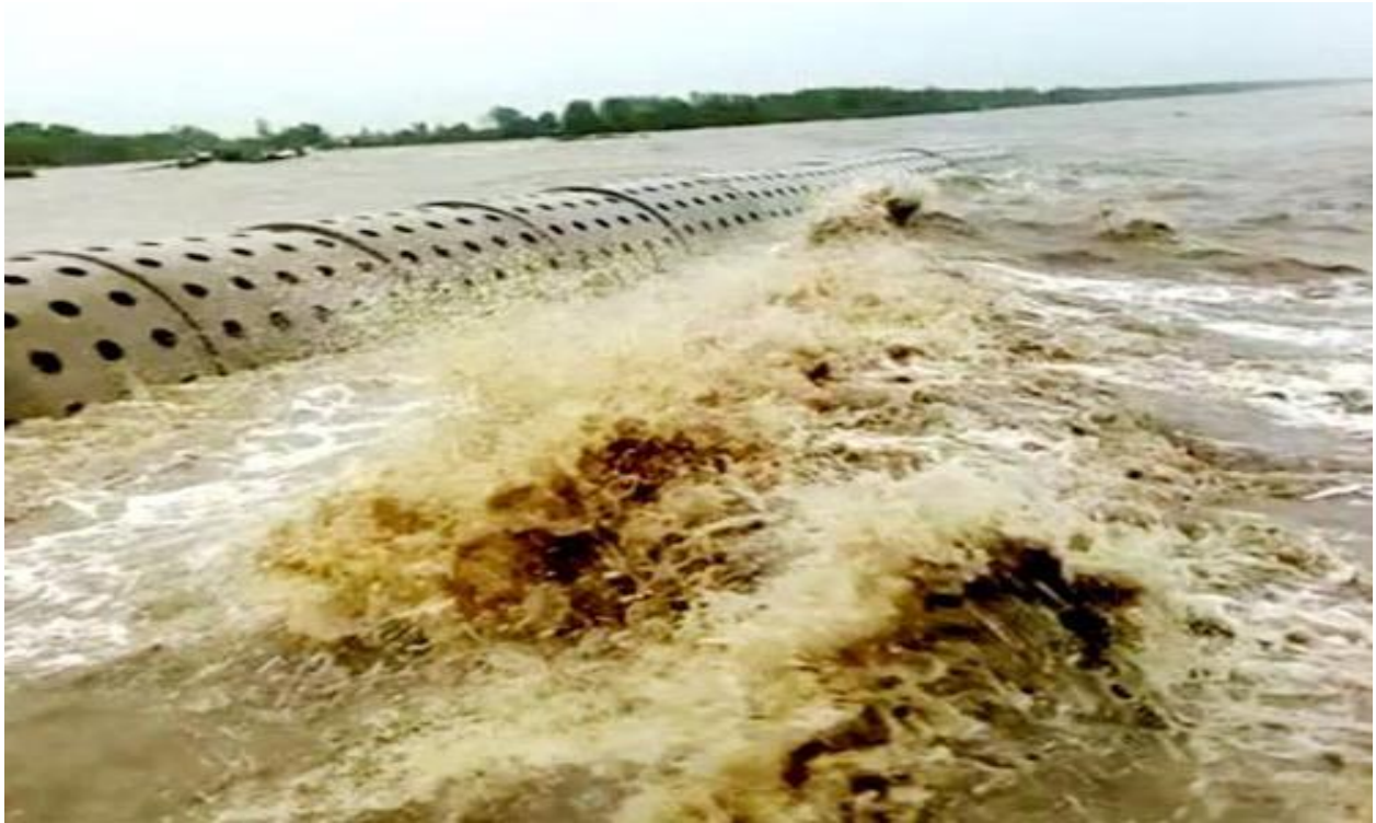
Đoạn đê trụ rỗng thử nghiệm
