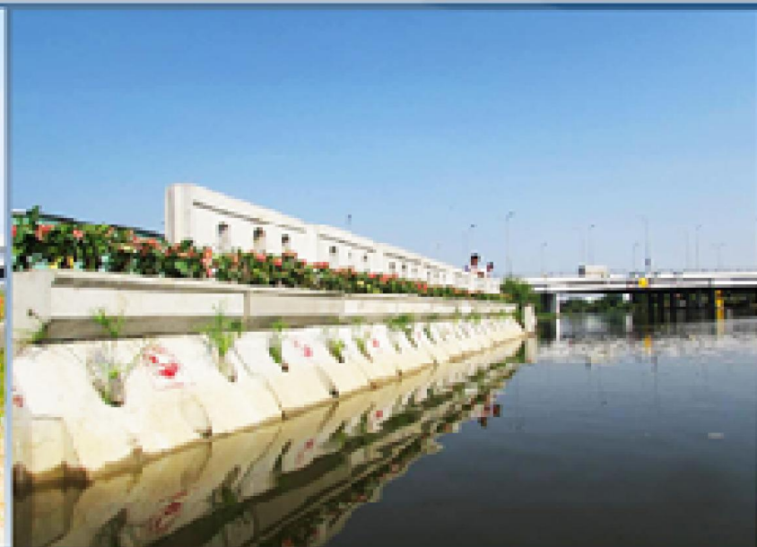
Lắp đặt Cấu kiện lắp ghép bảo vệ bờ sông, hồ và đê biển tại kênh Tham Lương, TPHCM
