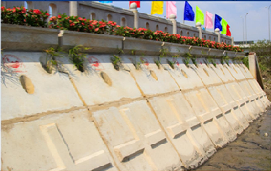
Lắp đặt Cấu kiện lắp ghép bảo vệ bờ sông, hồ và đê biển tại kênh Tham Lương, TPHCM
