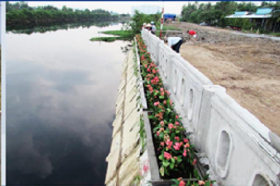
Lắp đặt Cấu kiện lắp ghép bảo vệ bờ sông, hồ và đê biển tại kênh Tham Lương, TPHCM
