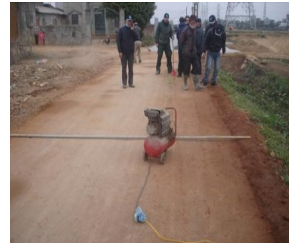
Bước 10: Công tác làm lớp mặt đường chống mài mòn (2 lớp đá dăm + nhựa đường)
