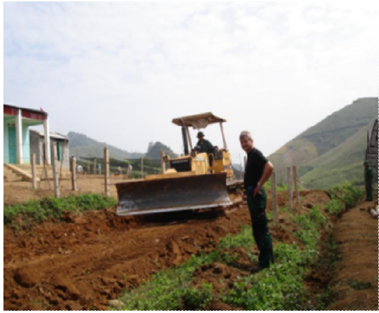
Bước 1: Tạo phẳng nền đường bằng máy ủi.
