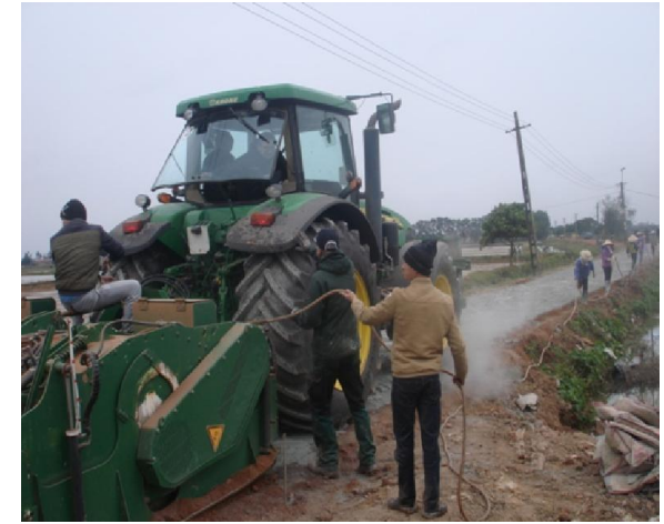
Bước 7: Phay trộn hỗn hợp lần 2 sâu 0,2 m, rộng 2,50 m + 0,5 m
