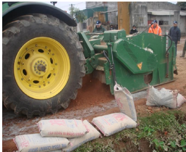
Bước 4: Phay trộn lần 1 gồm đất + phụ gia ROADCEM, chiều sâu phay 2/3 chiều sâu thiết kế. Phay lần 1, sâu 0,15 m, rộng 2,5 m + 0,5 m, tưới nước 80 l/m 2
