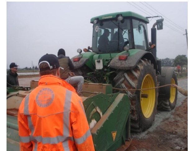
Bước 4: Phay trộn lần 1 gồm đất + phụ gia ROADCEM, chiều sâu phay 2/3 chiều sâu thiết kế. Phay lần 1, sâu 0,15 m, rộng 2,5 m + 0,5 m, tưới nước 80 l/m 2
