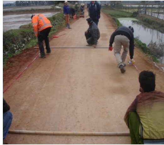
Bước 2: Cắm mốc, nắn tuyến và chia đoạn thi công
