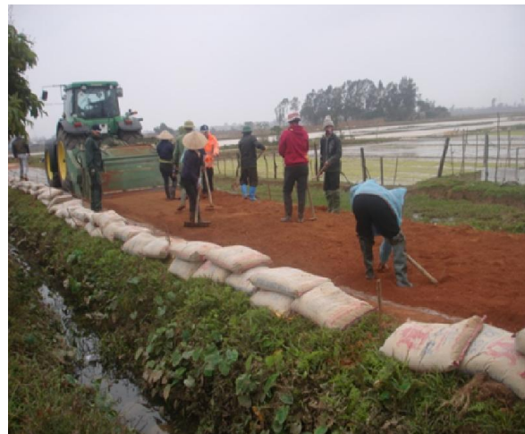
Bước 4: Phay trộn lần 1 gồm đất + phụ gia ROADCEM, chiều sâu phay 2/3 chiều sâu thiết kế. Phay lần 1, sâu 0,15 m, rộng 2,5 m + 0,5 m, tưới nước 80 l/m 2
